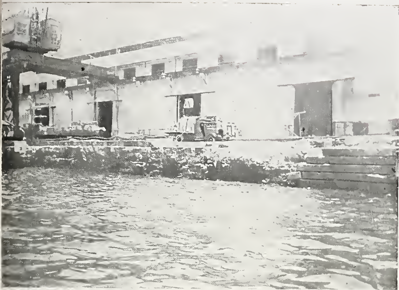
RECIFE — Estado atual do cais de 10 metros, em frente ao armazém n.º 2
