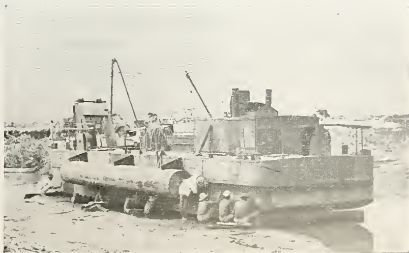
A draga "Morais Rêgo" em reparos
