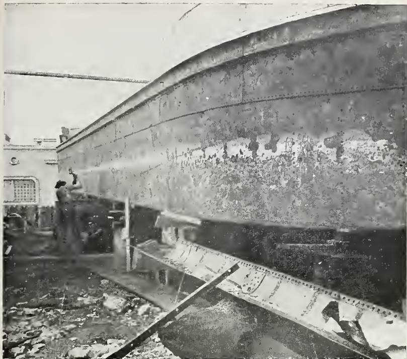
Estado do casco antes das obras
