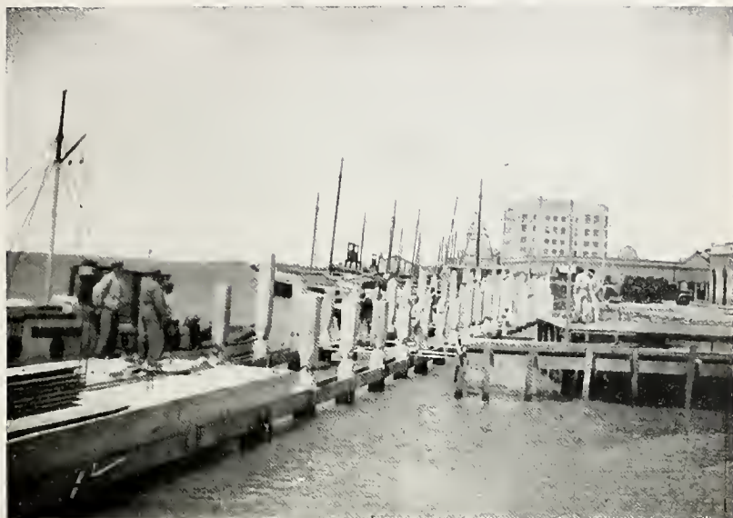
Construção do cais de saneamento
