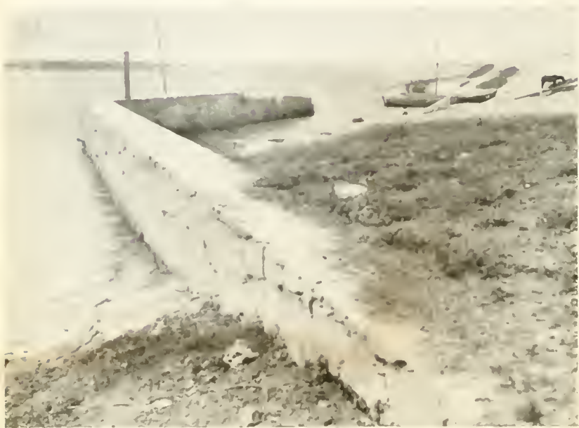
Vista do cais de saneamento, no local do canal da Barra, a margem direita do rio Itapemirim, mostrando o prosseguimento de 30 metros executado pelo 12.º DPRC.
