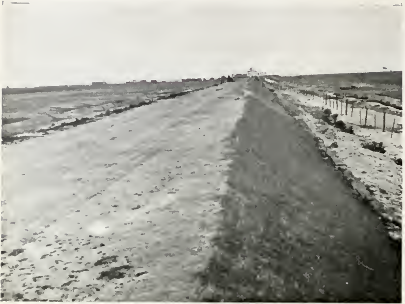
Enleivamento da estrada de acesso, concluído
