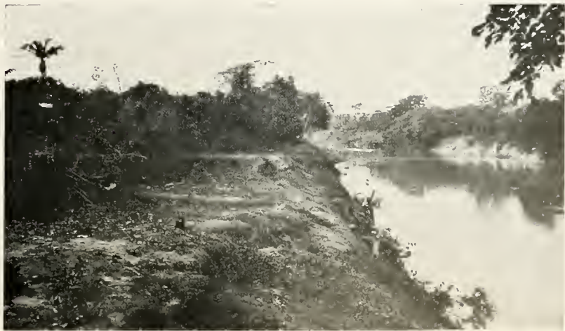
Trecho do rio Mearim, já beneficiado
