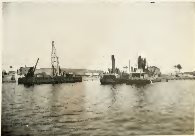
Draga "Afonso Pena", em batelão "Simone" e bate-estacas, em serviço no cais do Cajú.
