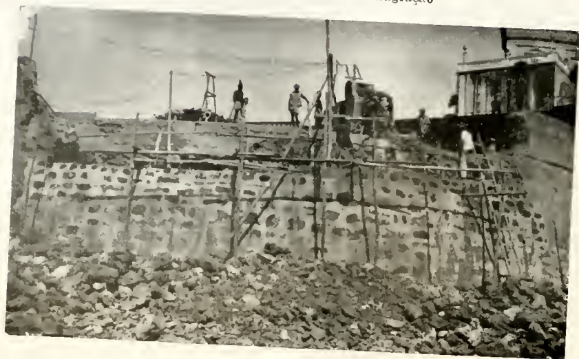
O muro em reconstrução
