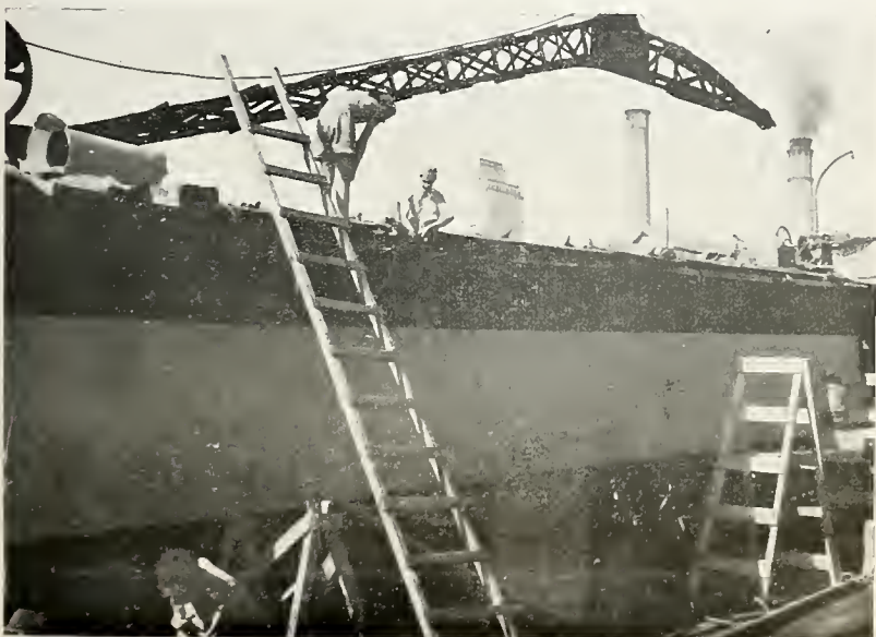
Substituição das chapas do casco
