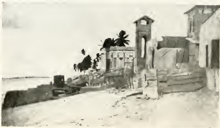
OLINDA — Trechos da Praia dos Milagres atacados pelo mar
