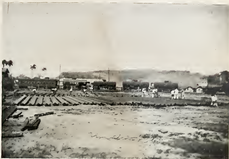
Pintura das estacas-pranchas de aço destinada à construção da muralha do prolongamento do cais do Cajú. — Ao fundo o morro do Cemitério, que está sendo desmontado para servir de atêrro do terraplino.
