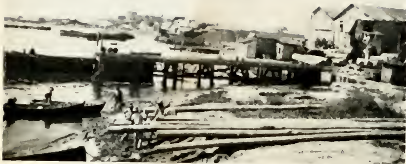
Trecho do litoral a ser ocupado pelo futuro cais
