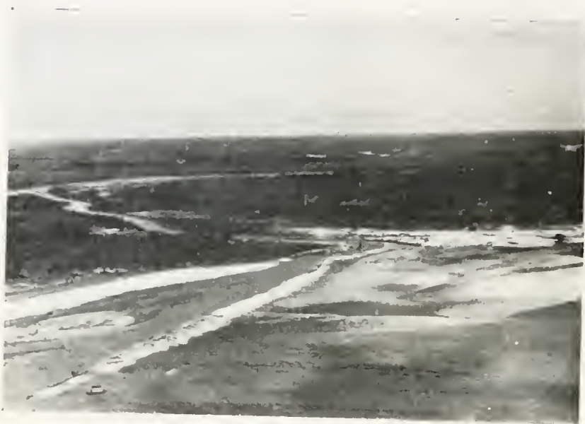
Canal aberto pela draga "Parnaíba", através do banco formado. Vê-se ao fundo, a draga aprofundando a boca do igarapé do VIDAL.
