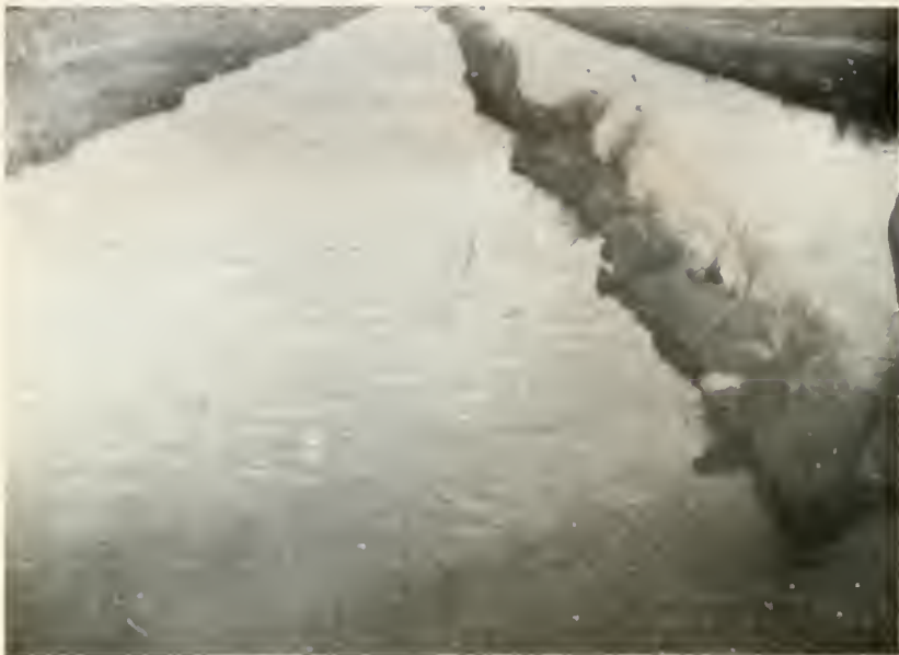
Vista do canal já aberto, vendo-se ainda o canal antigo
