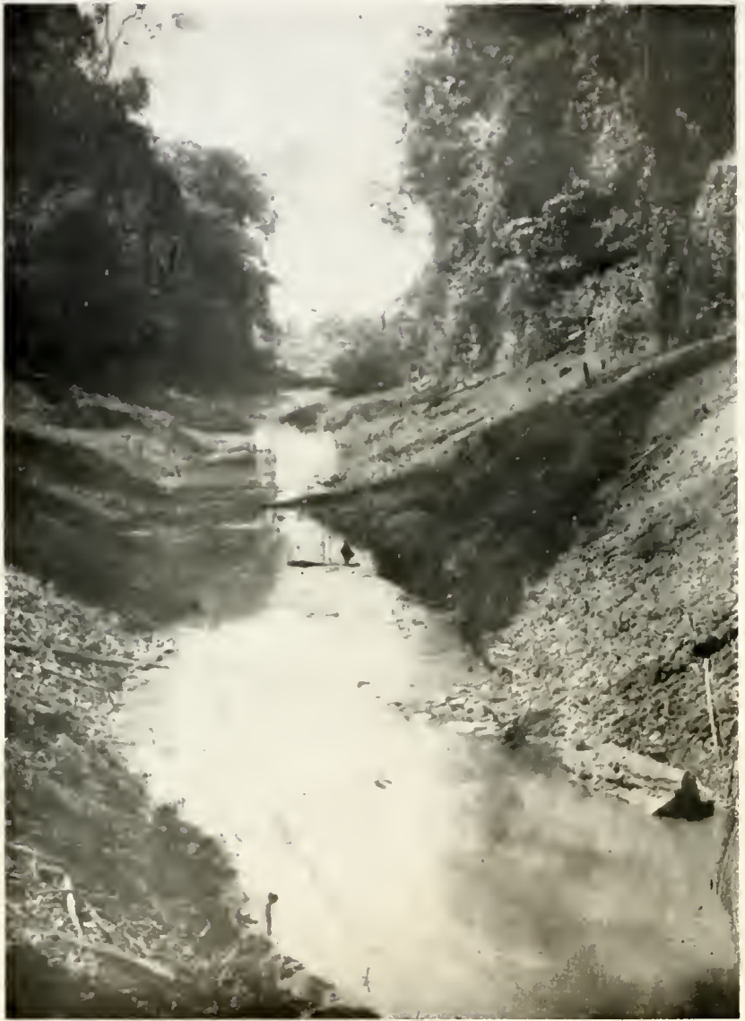
Destocamento do leito do Paracuiba
