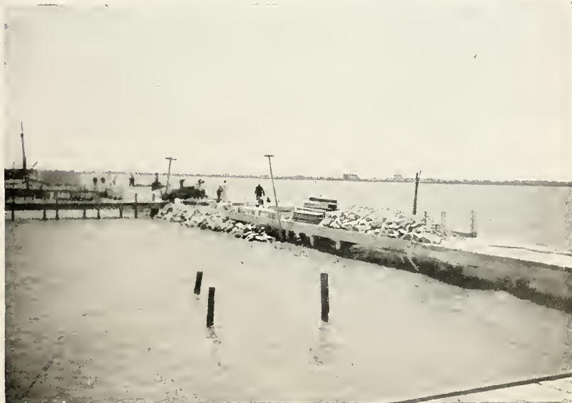
Outra vista da construção do cais de saneamento
