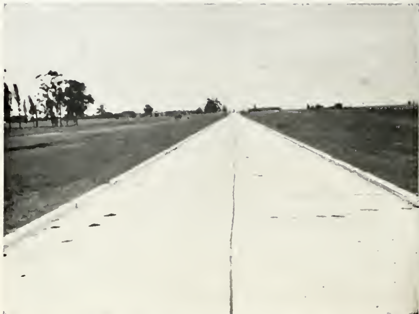
Tiecho concluído da estrada de ligação do pórtio à cidade de Santa Vitória do Palmar
