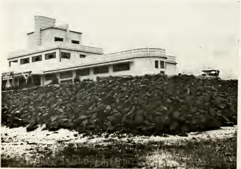
Enrocamento de proteção do terrapleno
