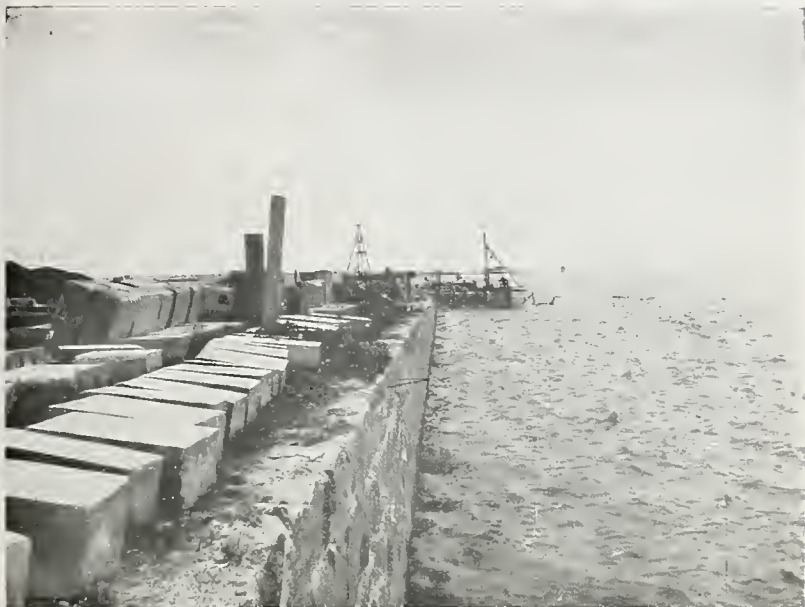
Trecho de cais concluído, vendo-se as coberturas premoldadas para a colocação
