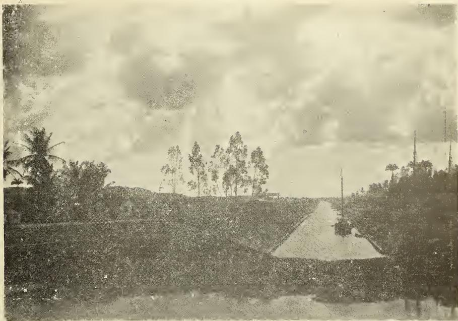
*Canal de Guiana, vendo-se no primeiro plano a bacia de evolução a montante do canal, parcialmente obstruída pela vegetação aquática*
