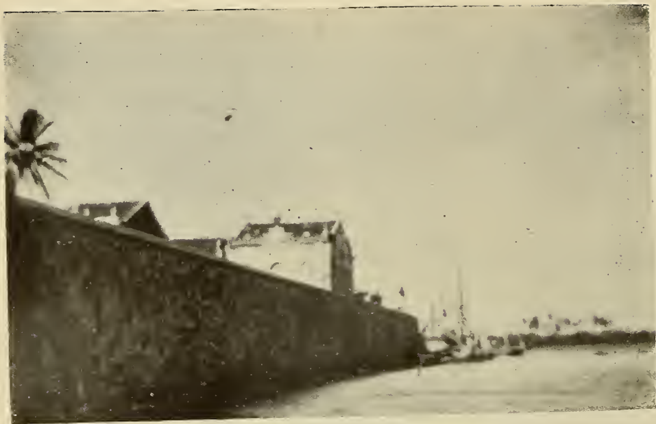
Vista do último trecho do Cais, em Canavieiras
