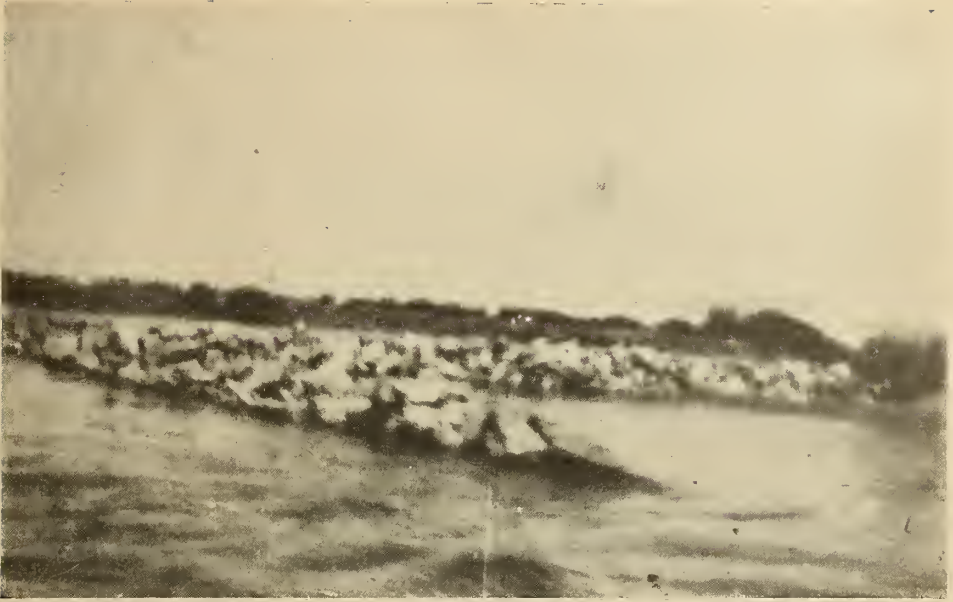
Espigão E-17, enraizado na Ilha dos Anozes, com 80 metros de avançamento, em espigão fechado, na Ilha da Goiabeira — S. J. da Barra
