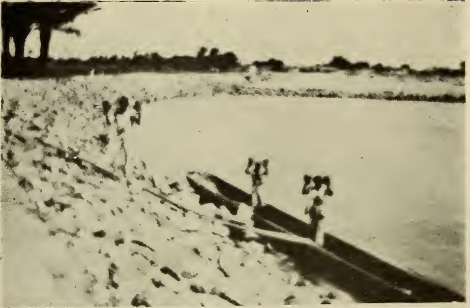
Revestimento da margem à montante de Bel Monte
