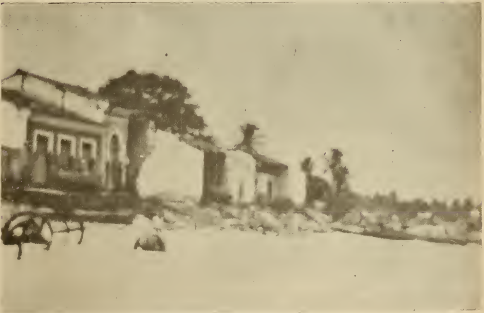
Praia de Camalaú — Casas destruídas pela erosão da margem
