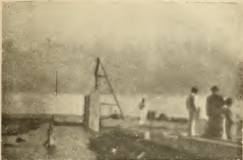
Construção do Cais de Saneamento
