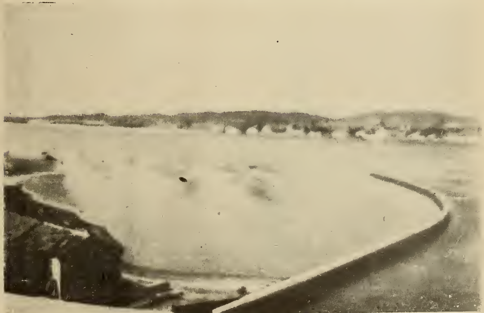
Guia corrente em construção na margem esquerda do Canal Itajuru — Cabo Frio
