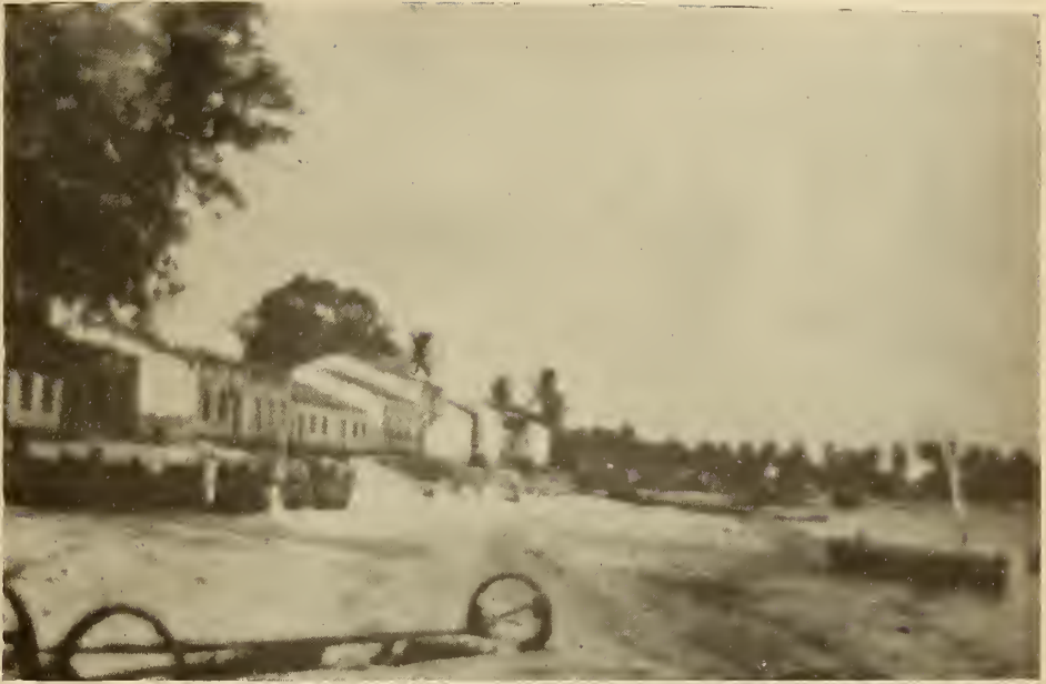
Praia de Camalaú — Casas destruídas pela erosão da margem
