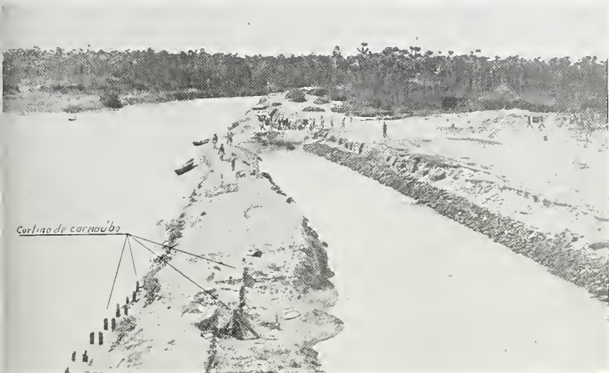
RIO PARNAÍBA — Trabalhos em andamento no Canal de São José.
