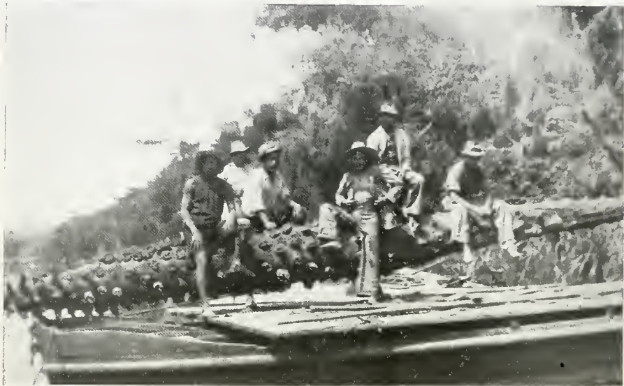
PARANÁ — RIO IGUAÇU — Serviço de Obras Subsidiárias (Desobstrução do leito).
