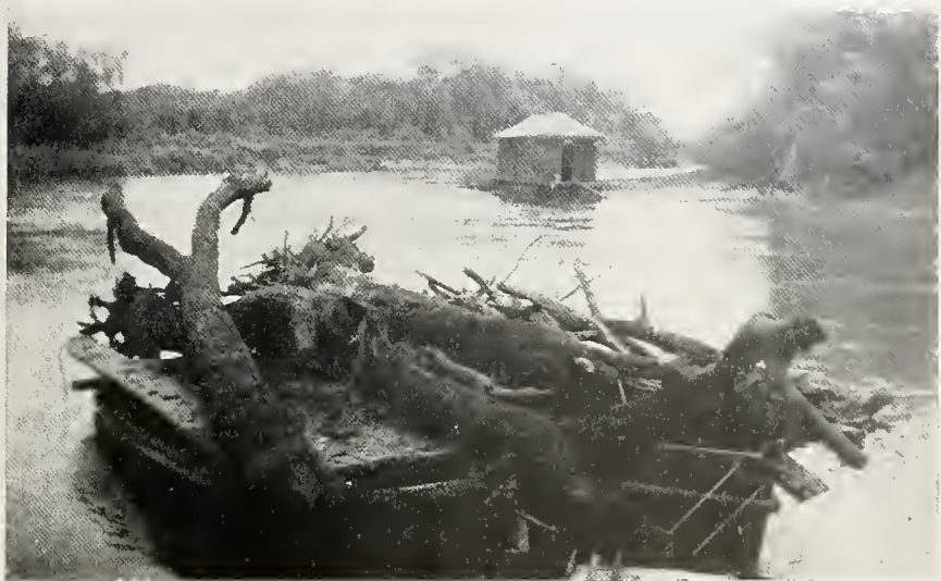
PARANÁ — RIO IGUAÇU — Serviço de Obras Subsidiárias (Desobstrução do leito). Ao fundo: margem desmatada.
