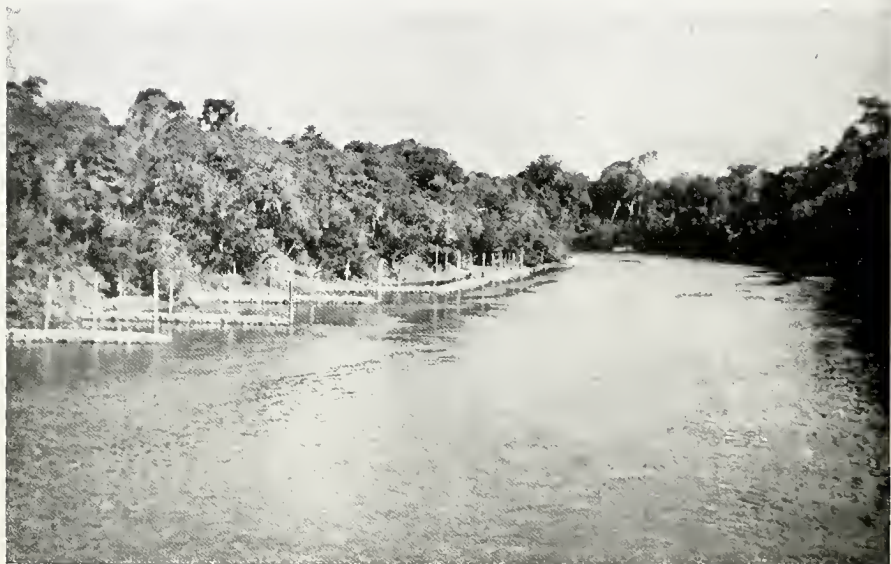
PARANÁ — RIO IGUAÇU — Espigões do 6.º trecho em construção nas Aduelas. Km. 10.
