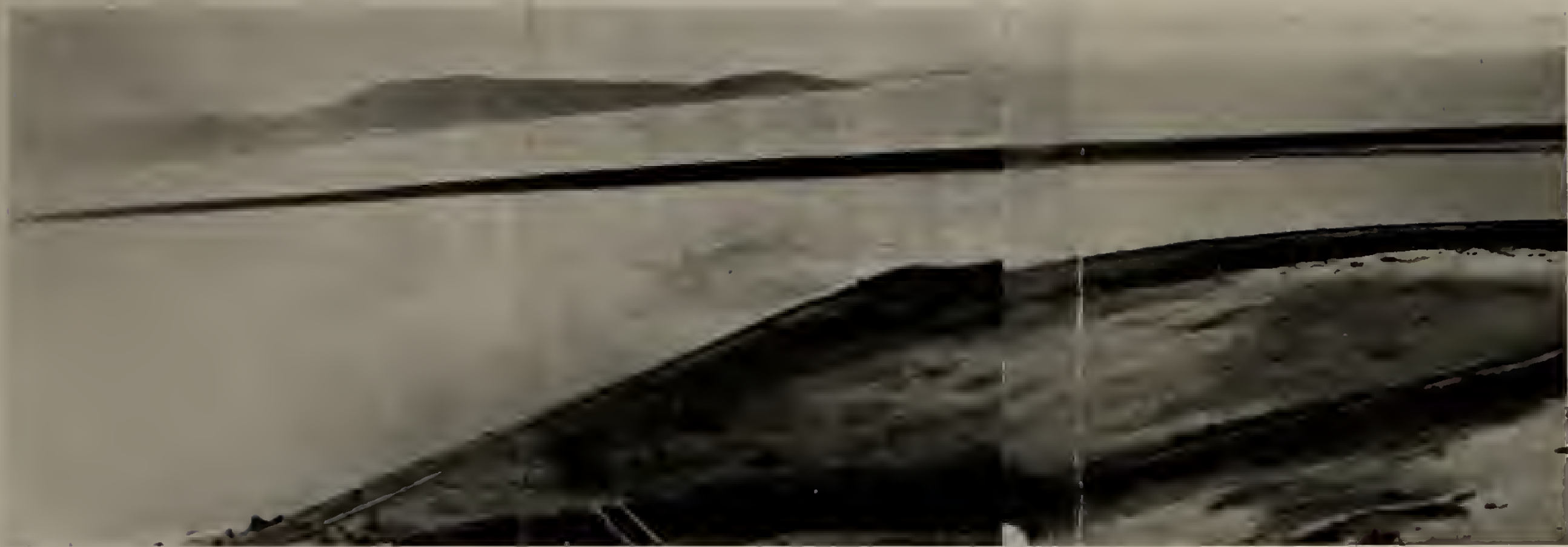
SANTA CATARINA — PORTO DE LAGUNA — Obras fixas construídas para aprofundamento e regularização da barra e canal de acesso.
