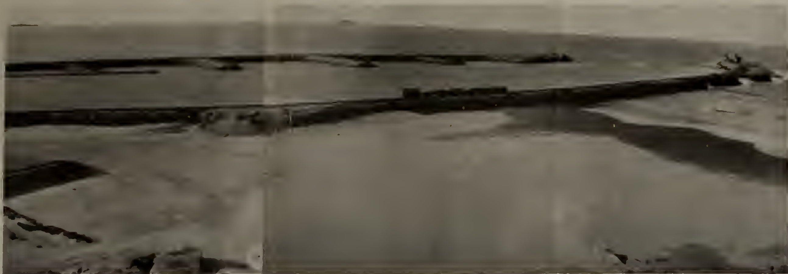
SANTA CATARINA — PÓRTO DE LAGUNA — Obras fixas construídas para aprofundamento e regularização da barra e canal de acesso.
