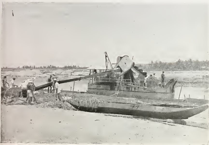
SERGIPE — CANAL DE POMONGA — Serviço de limpeza e desobstrução , pela draga "Santa Maria".
