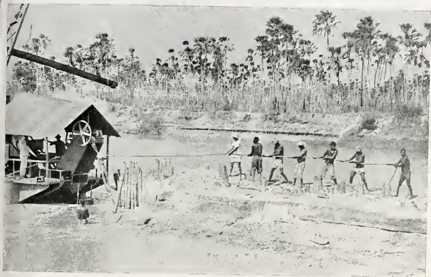
RIO PARNAÍBA — A draga "Rio Parnaíba" auxiliando a retirada de troncos do leito do rio.
