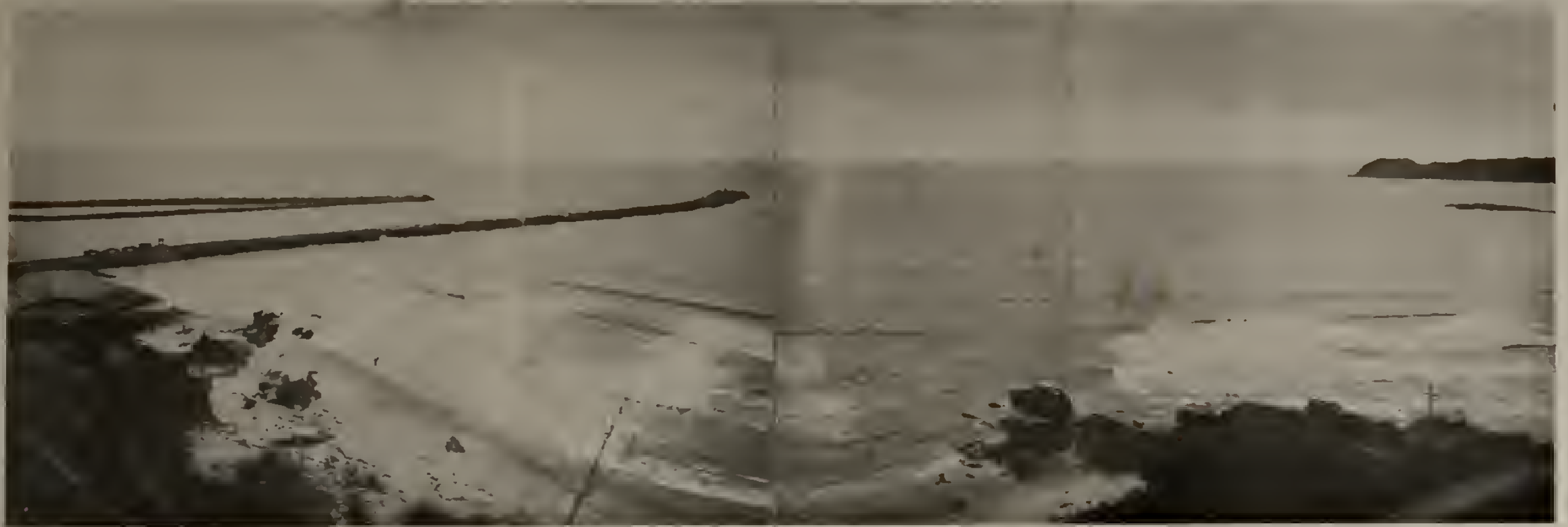
SANTA CATARINA — Pôrto de Itajaí — Sistema de obras fixas de entrocamento construídas para o aprofundamento e regularização da barra e canal de acesso no pôrto
