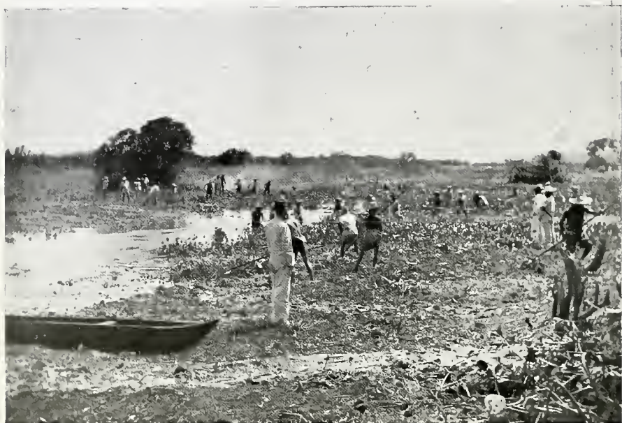
SERGIPE — RIO SIRIRÍ — Desobstrução partindo de juzante.
