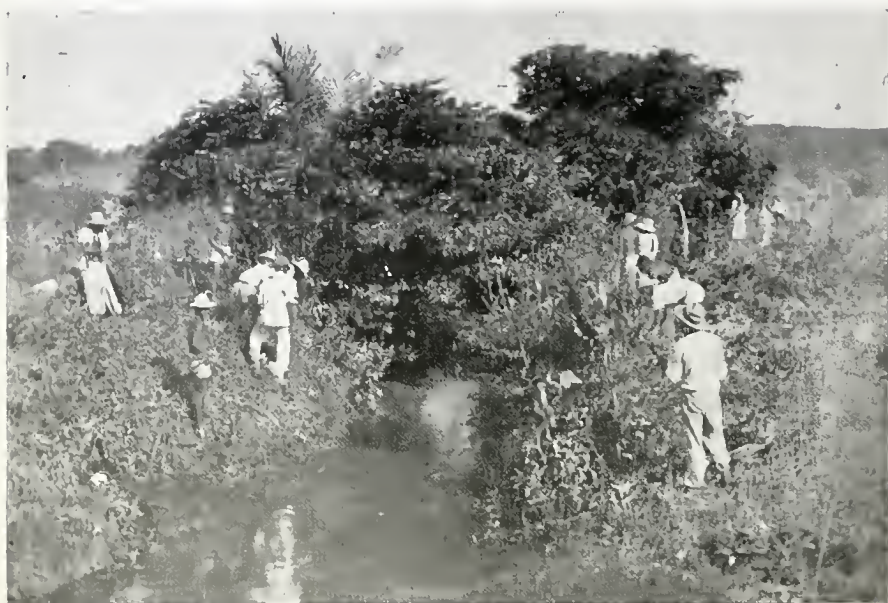
SERGIPE — RIO POXIM — Em serviço de limpeza e desobstrução.
