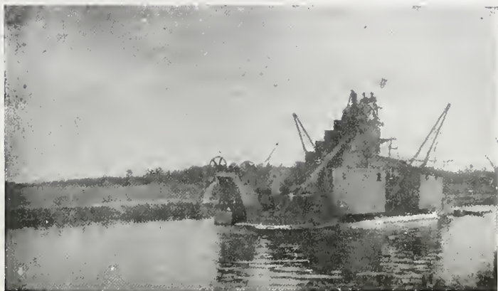
MARANHÃO — Draga "Morais Rêgo" em serviço no Canal "Aurá".
