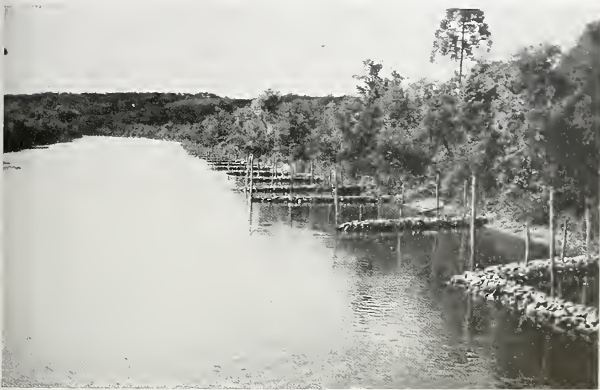
PARANÁ — RIO IGUAÇU — Espigões do 6.º trecho em construção nas Aduelas. Km. 10. Serviço de obras fixas.
