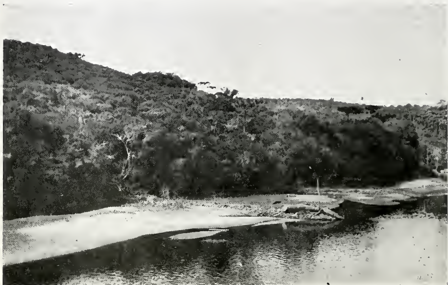
PARANÁ — RIO IGUAÇU — Espigões do 4.º trecho (Km. 8) 18 meses após a construção.
