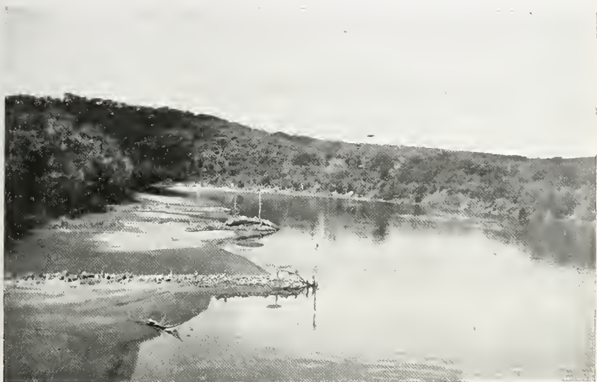
PARANÁ — RIO IGUAÇU — Espigões do 4.º trecho (Km. 8) (18 meses após a construção).
