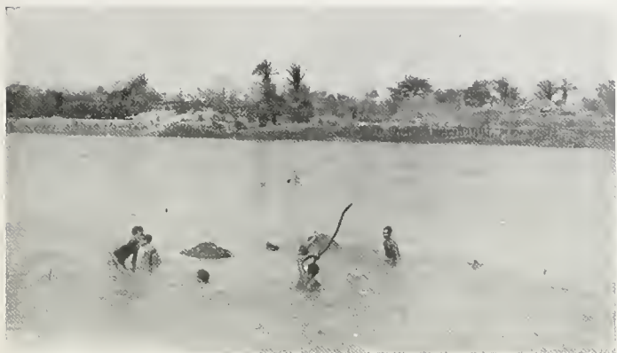
RIO PARNAÍBA — Trabalho de retirada de um grande tronco do leito.
