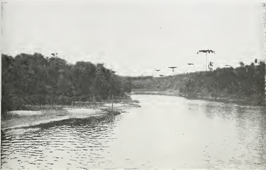
PARANÁ — RIO IGUAÇU — Espigões do 7.º trecho (Km. 13). Vista de juzante mostrando a praia formada.
