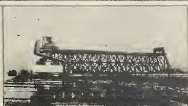
—PORTO DE GENOVA— MOLHE PRINCIPE UMBERTO E TITAN PARA COLLOCAÇÃO DOS BLOCOS CYCLOPICOS
