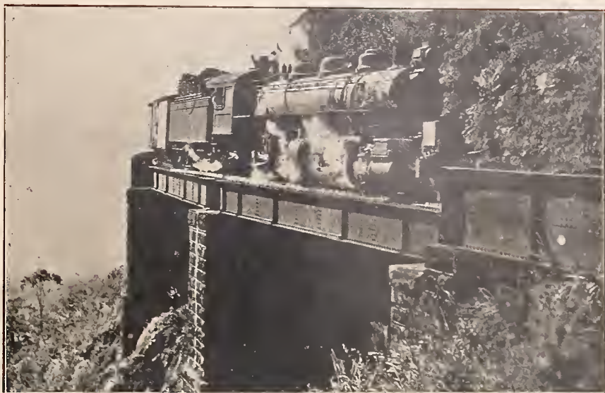
E. F. Paraná — Viaducto Carvalho.
