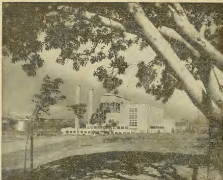
Usina Termelétrica de Piratininga, da São Paulo Light Power C. a Ltd. Construída em 26 meses. 200 000 kw
