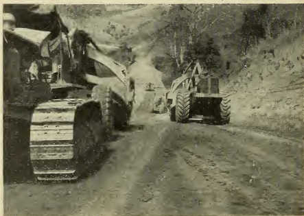
Rodovia Rio-Bahia — Trecho de Água Vermelha
