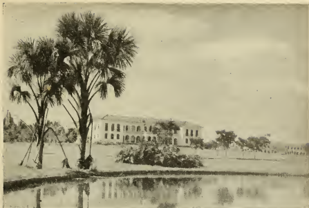
Edifício sede do Instituto de Ecologia e Experimentação Agrícola km 47 — Rodovia Rio-São Paulo
