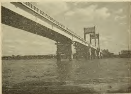
Ponte rodoferroviária com 800 m de comprimento, sobre o rio São Francisco, ligando Juazeiro (Bahia) a Petrolina (Pernambuco). Concluída em 1953.
