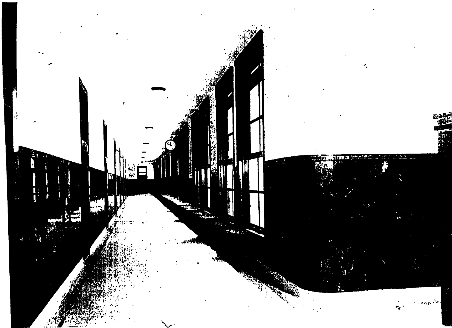
VISTA DA GALERIA DO PAVIMENTO TIPO
