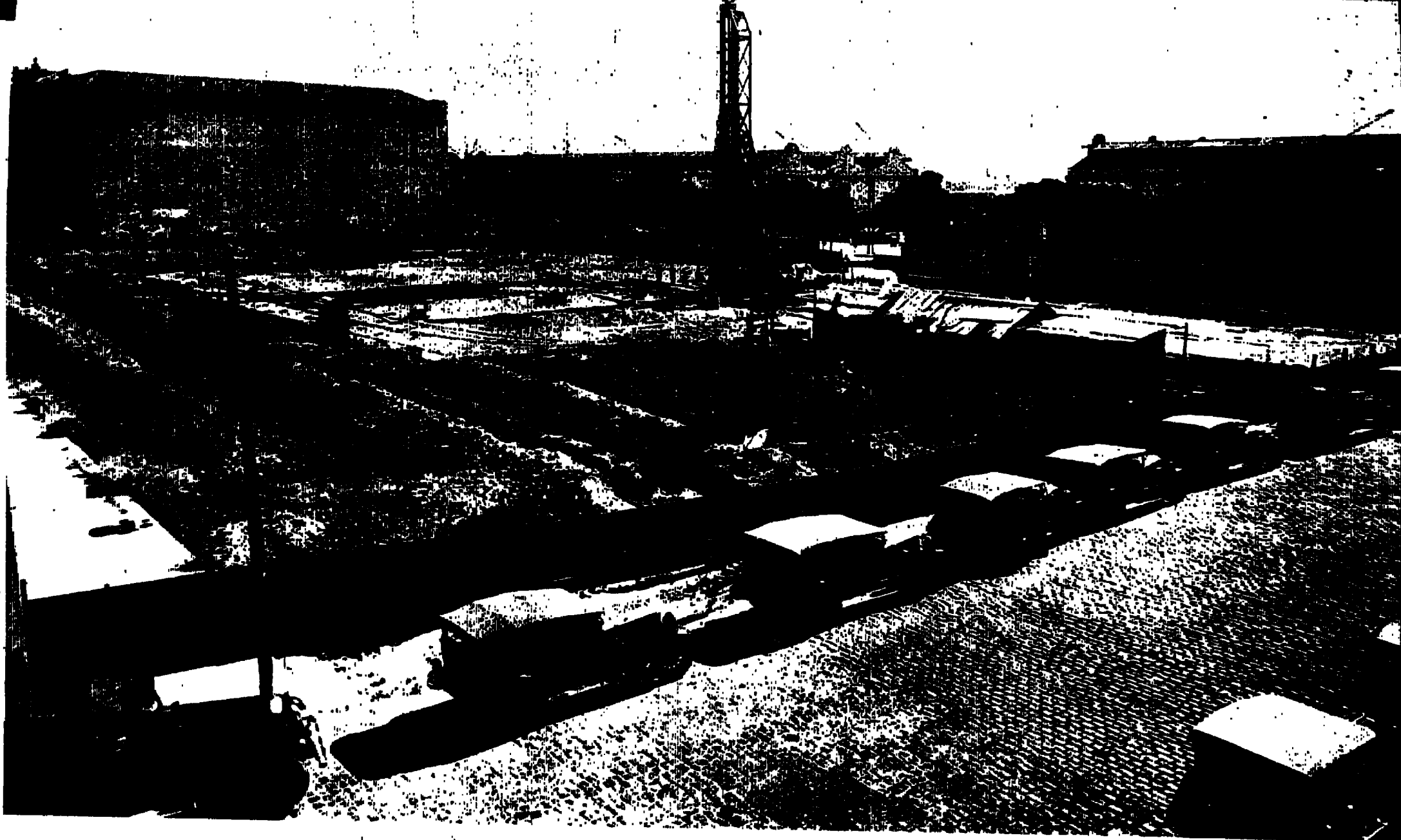
Vista do terreno onde está sendo construído o novo edifício da Alfândega do Rio de Janeiro; Guarda-Moria e Laboratório Nacional de Análises
