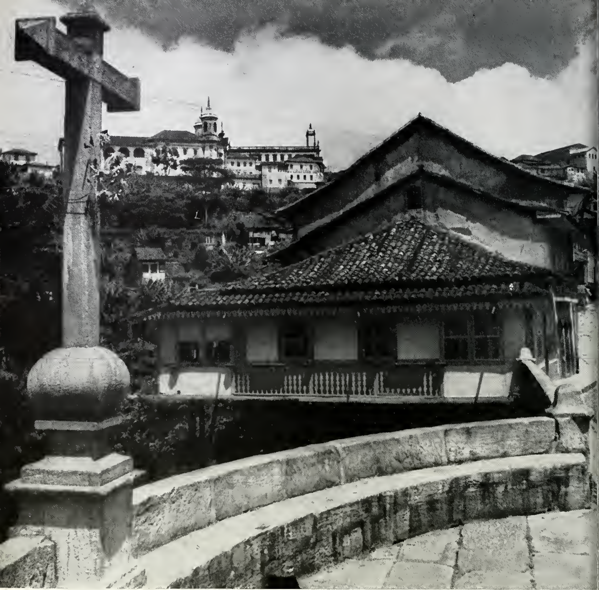
195. A ponte de Marília, em Ouro Preto. Aspecto parcial. Foto Rádio Inconfidência de Minas Gerais.
