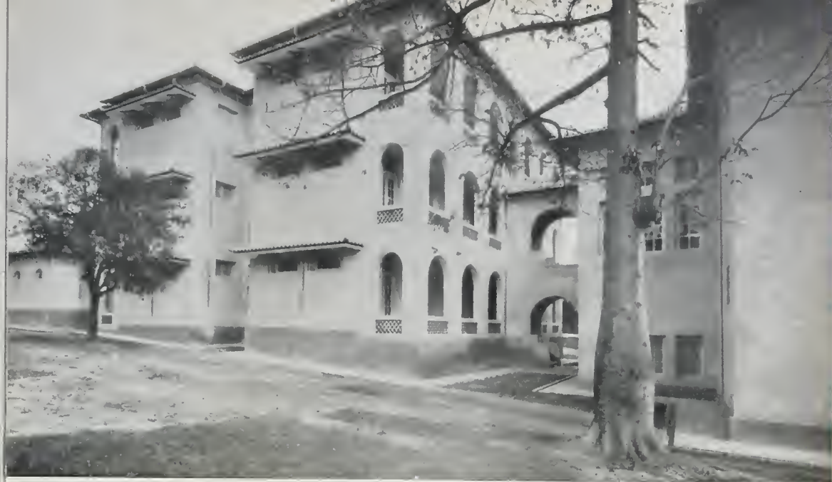
364. Escola Uruguai, do Distrito Federal, construção em vários blocos (1928-1930). Vista lateral tomada do pátio da escola, uma das maiores edificadas na administração Antônio Prado Júnior.
