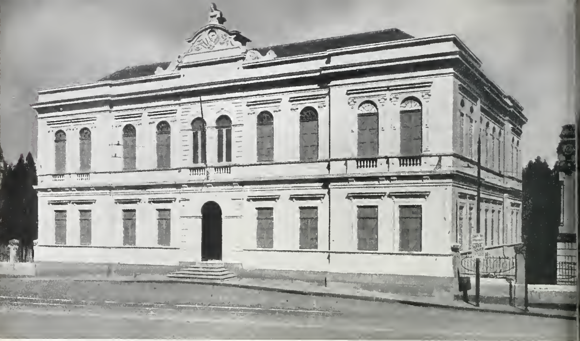
400. Escola de Engenharia de Pórtó Alegre, no Rio Grande do Sul. Instituto de Engenharia. Fachada principal.
