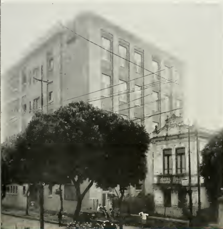
361. A Escola Profissional Paulo de Frontin, do Distrito Federal, destinada à educação doméstica e profissional de moças, já em seus novos edi- fícios construídos e instalados na administração Antônio Prado Júnior (1926-1930).
