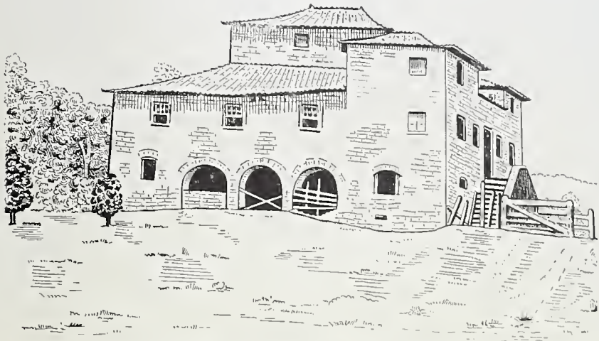
27. Casa Grande do Engenho de Magaípe, construção do século XVII. FREYRE, Gilberto, Casa Grande y Senzala.
