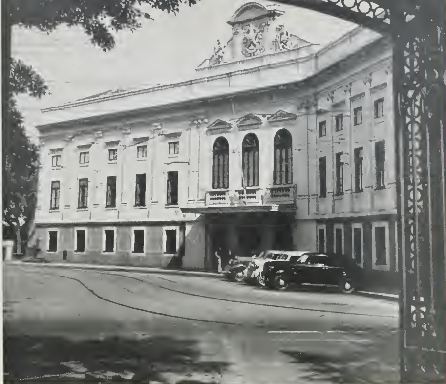
396. Faculdade Nacional de Direito do Rio de Janeiro, hoje instalada no edifício do antigo Senado, primitivamente Palácio do Conde dos Arcos.
