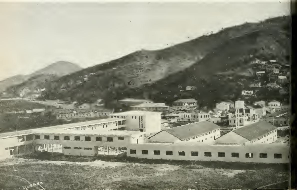
411. Escola Técnica de Vitória, no Espírito Santo. Vista de conjunto. Foto do Serviço de Documentação do Ministério da Educação e Saúde.
