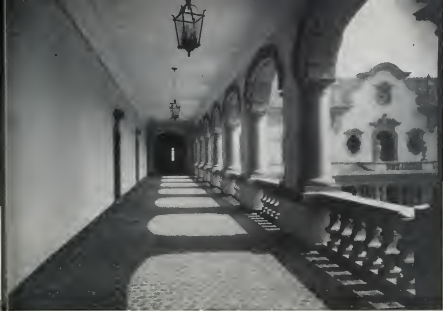
415. Instituto de Educação do Distrito Federal. Uma das amplas galerias do terceiro pavimento, abrindo para o suntuoso pátio central. — Foto NICOLAS, Rio, 1930.
