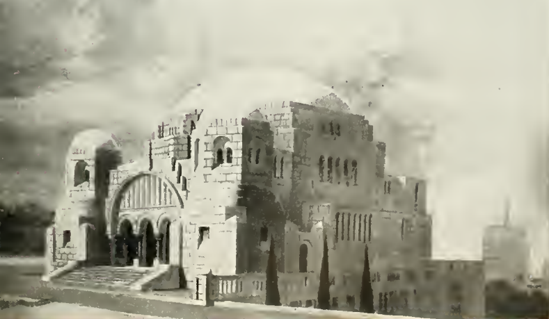
163. Templo Beth-Israel. Pro- jeto da Sinagoga de S. Paulo, em construção e já quase concluído.
