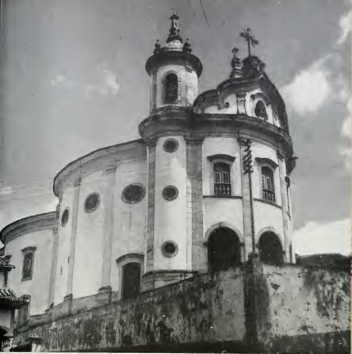
271. Igreja do Rosário. Aspecto externo. Ouro Preto. Foto Rádio Inconfidência de Minas Gerais.
