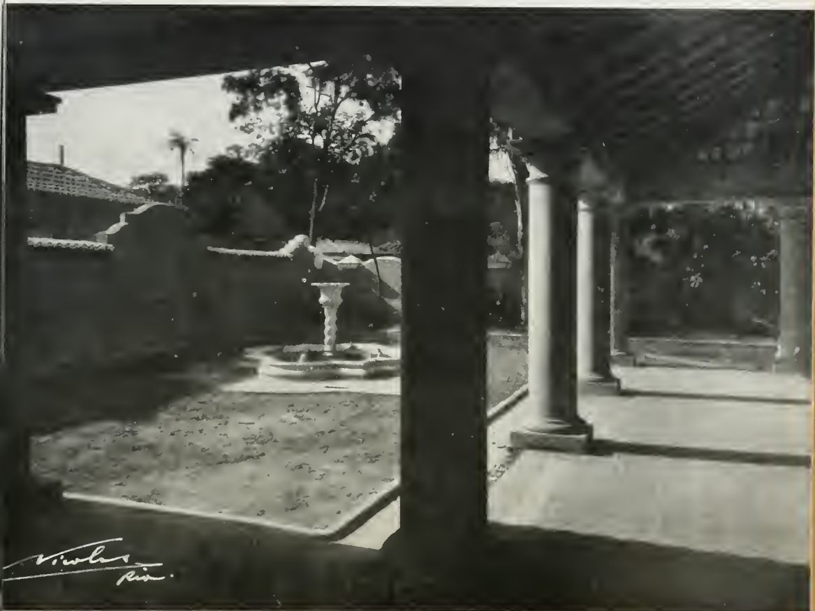
365. Escola para débeis físicos, na Quinta da Boa Vista (Distrito Federal, 1926-1930). Galeria e lonta de um dos pátios. — Foto NICOLAS.
