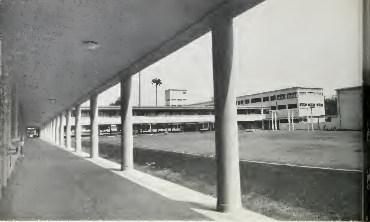
410. Escola Técnica Nacional do Distrito Federal. Uma das galerias do pátio central. Foto do Serviço de Documentação do Ministério da Educação e Saúde.
