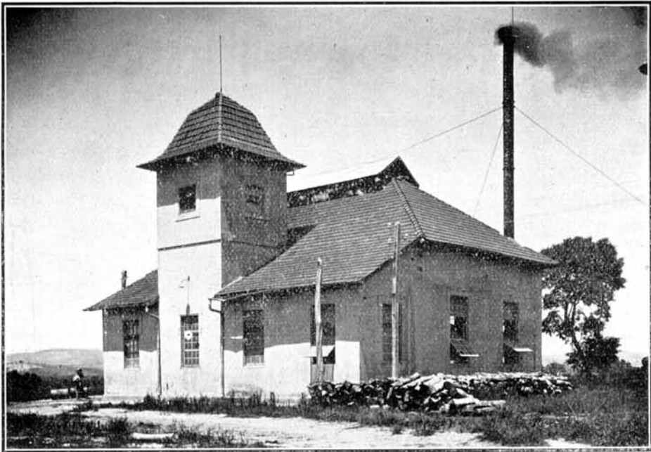
Usina Electrica Taquara — E. do Rio Grande do Sul
