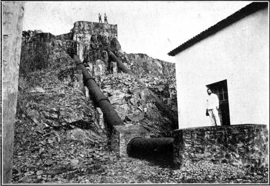
Castello d'água da Usina Municipal de Passo Fundo — Rio Grande do Sul
