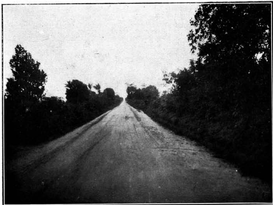
Estrada Norte (revestimento natural silico-argiloso). Trecho «Chá da Onça» — Estado de Pernambuco
