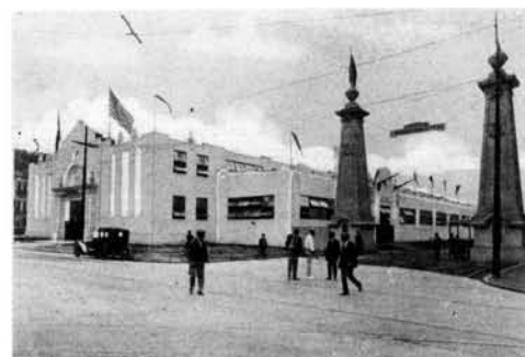
Pavilhão das Grandes Industrias Norte-Americanas
