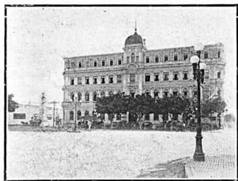
Inspectoria das Estradas de Ferro
