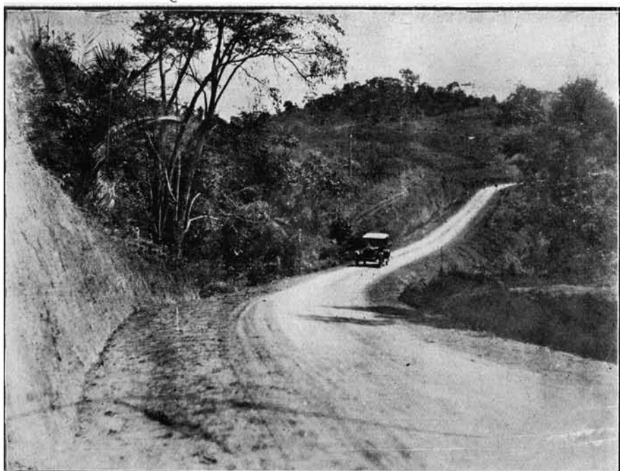
Estrada de rodagem de Cataguazes a Ubá — Estado de Minas Geraes
