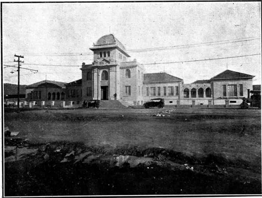
Escola Maternal de Bello Horizonte — Estado de Minas Geraes
