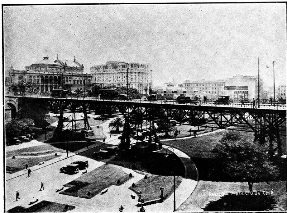
Viaducto do Chá — São Paulo
