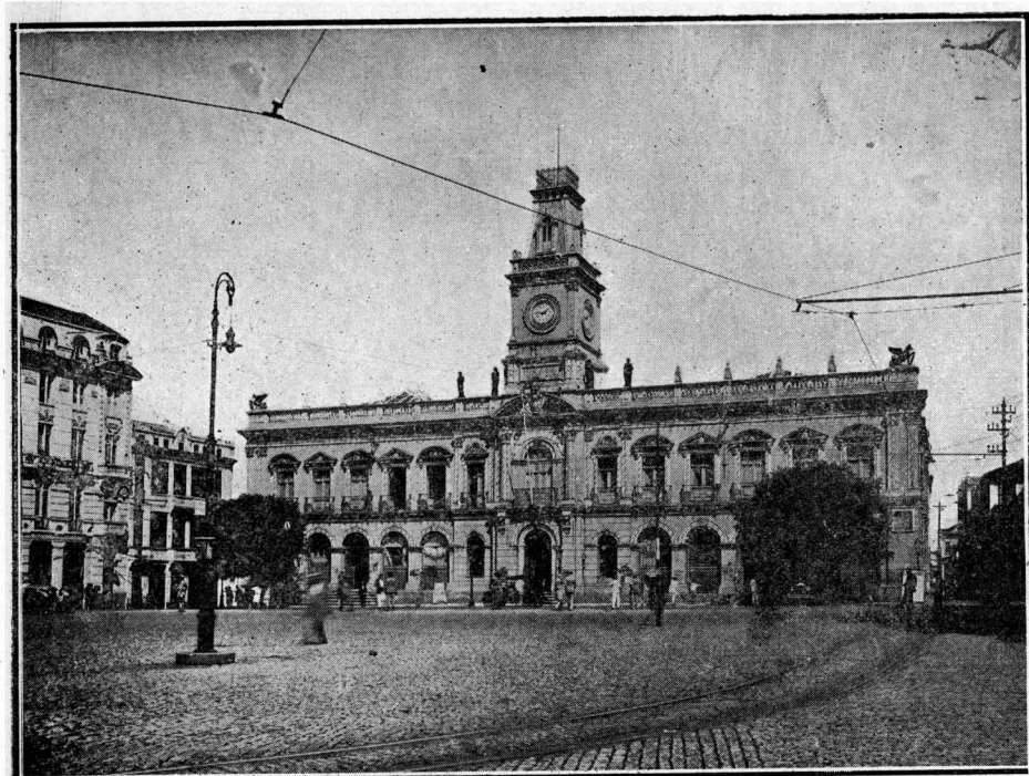
Camara Municipal, praça Rio Branco — capital do Estado da Bahia
