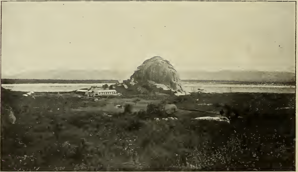
ÉTAT DU CEARÁ. — Vue des barrages de Quixadá.
