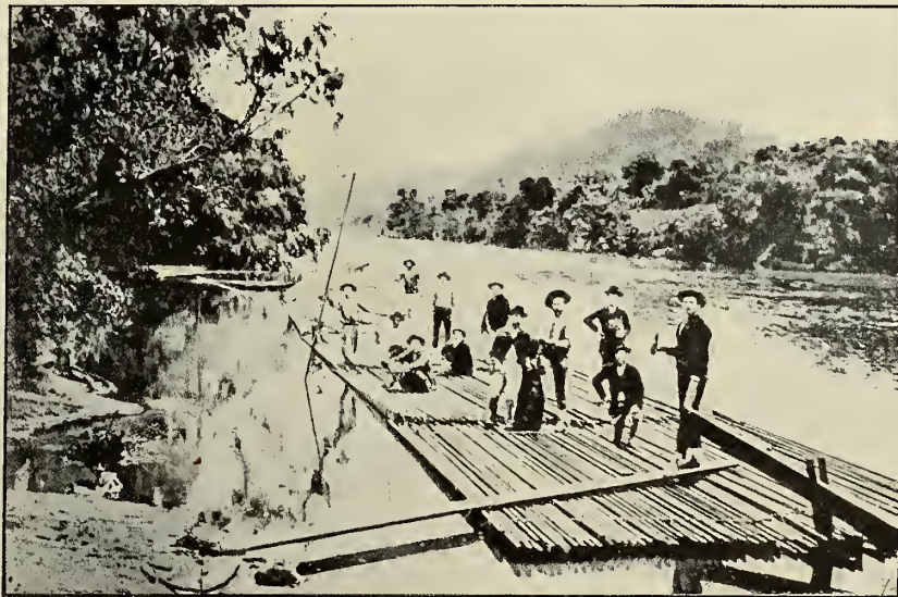
ÉTAT DE RIO GRANDE DO SUL. — Train de bois sur le fleuve Cahy.
