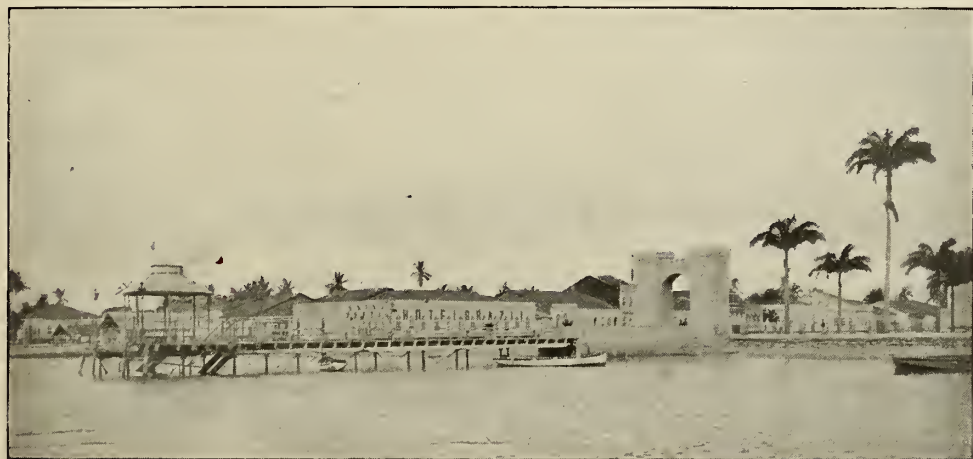
ÉTAT DE SERGIPE. — Pont de débarquement à Aracajú.
