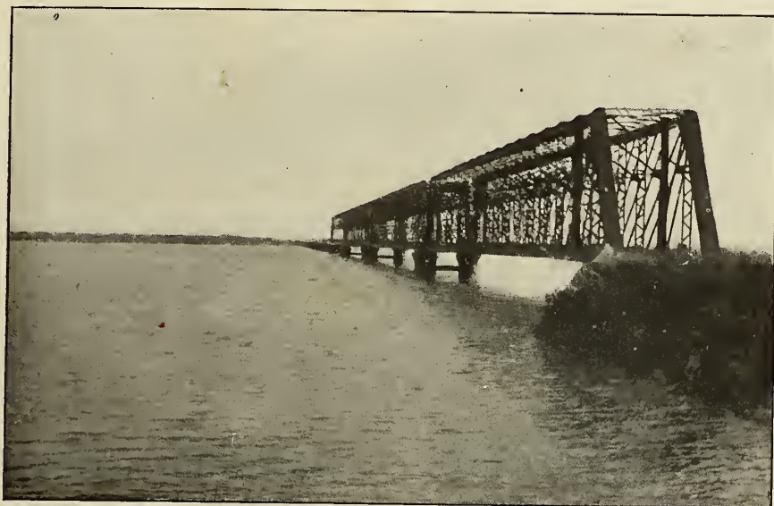
ÉTAT DE RIO GRANDE DO SUL. — Pont sur l' « Ibiculy ».
