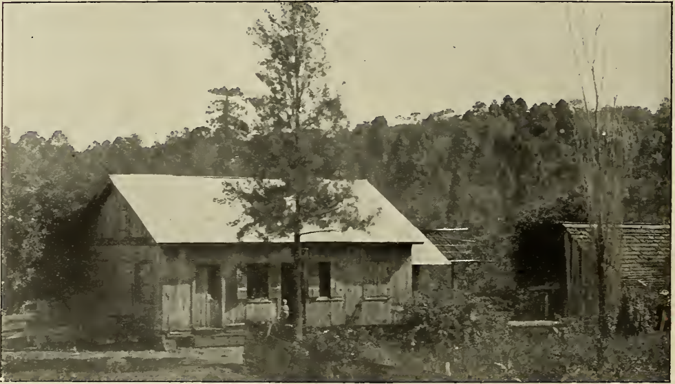
ÉTAT DE MINAS GERAES. — Maison d'un colon et dépendances.
