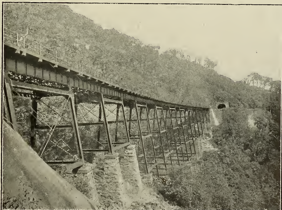
ÉTAT DE SÃO PAULO. — La ligne du São Paulo Railway.
