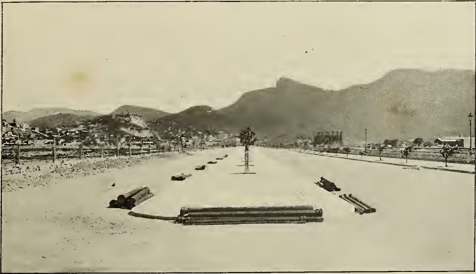
RIO DE JANEIRO. — Travaux du port.
