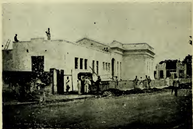
Aspecto das obras do edificio da Recebedoria das Rendas de Feira de Santana
