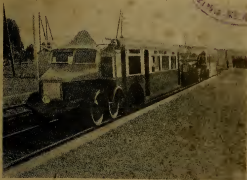
Auto-motriz - Michelin que conseguiu a velocidade de 95 kilometros entre St. Arnould - Chartres, e doptadas de rodas revestidas de borracha.
