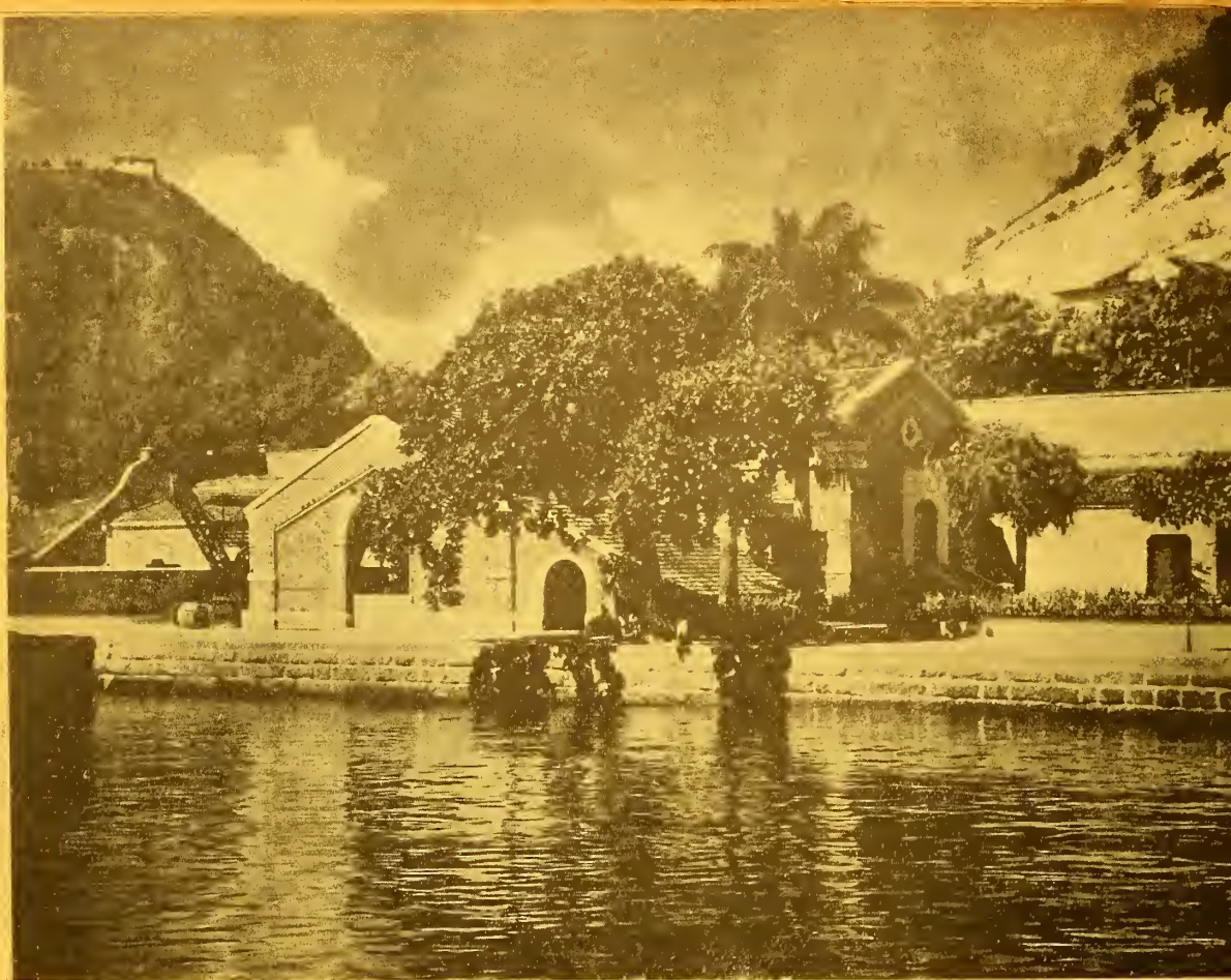
ESTAÇÃO ELEVATORIA DE BOTAFOGO
