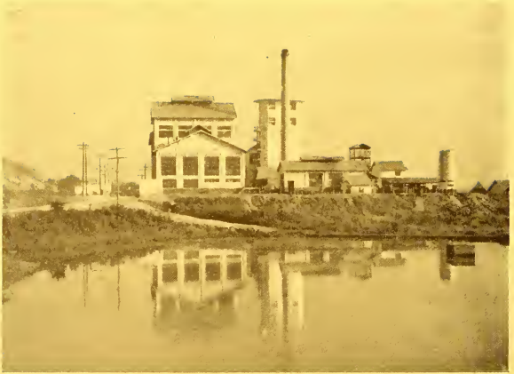
Fábrica de soda cáustica da Companhia Electro-Química Fluminense, à margem do rio Alcântara
