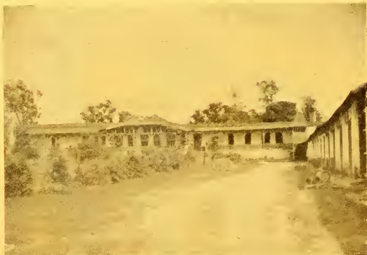
Fazenda de Guarindiba — Ao lado as senzalas transformadas em coudelaria e garage
