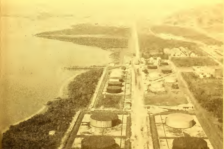
FIG. 30 e 31 — Vêem-se os cais de atracação dos petroleiros no Sabó e na ilha Barnabé, com seus depósitos para inflamáveis e os grandes depósitos para petróleo e gás situados na Alamoia. Em ambas as fotos percebem-se as grandes áreas de mangues ainda existentes. E do programa de ampliação do porto santista, traçado pela Cia. Docas, levar o cais do Sabó até a Alamoia e daí até o canal do Casqueiro. Fotos Antônio Lopes.
