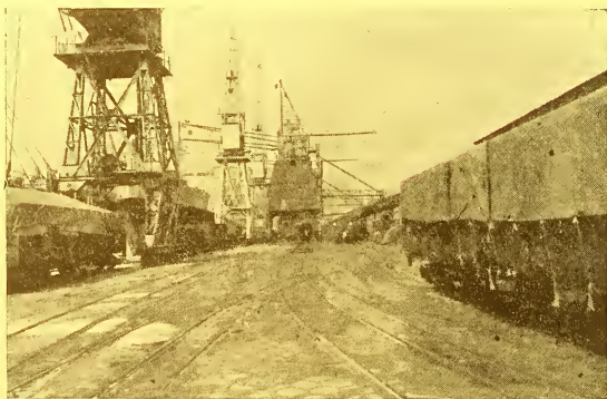
Fig. 33 — Aspectos de um pátio interno do cais, onde se destacam guindastes elétricos para carga geral, um sugador de trigo descarregando um “graneleiro” para o Moinho Santista, vagões da Santos-Jundiaí e da Sorocabana e à direita, acima dos vagões, uma esteira rolante que se estende por algumas centenas de metros. Foto Tomotoshi.
