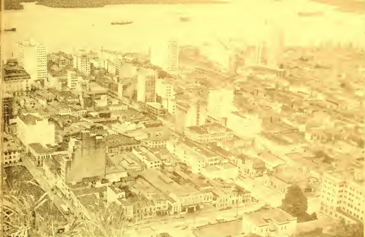
FIG. 28 — A foto focaliza a bacia de movimentação do porto, defronte à entrada do canal da Bertloga e da foz do rio Diana. Aparecem ainda uma parte do velho centro comercial e do antigo bairro do Paquetá. Foto Tomotoshi.
