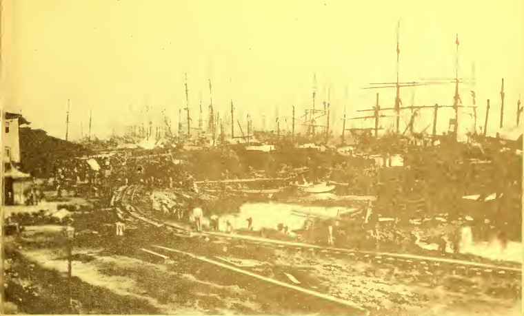
FIG. 21 — Visão caótica do pôrto no início do trabalho de sua construção; podemos fazer idéa das dificuldades encontradas por aqueles que se responsabilizaram pela transformação das pontes de madeira e dos velhos trapiches coloniais no moderno atracadouro de nossos dias.
