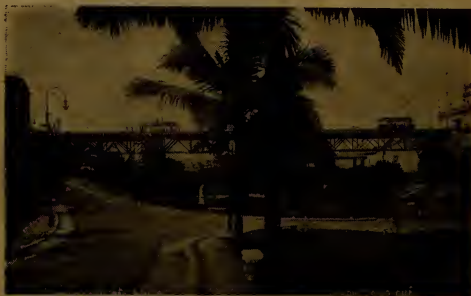
Viaducto do Chá
