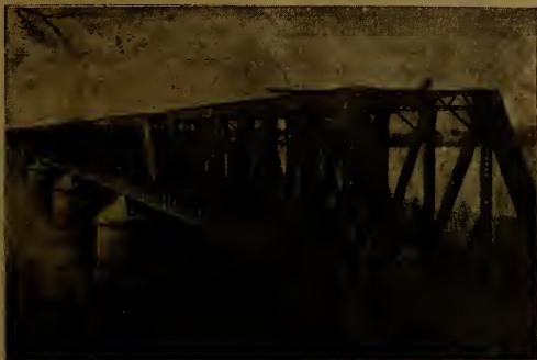
Ponte de Pirapóra
