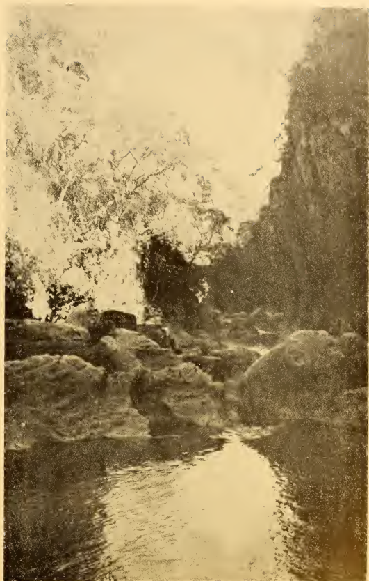
Boqueirão General Rondon — Os blocos atravancam o leito, obrigando a água a passar por tuneis
