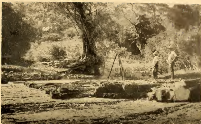
Este belo detalhe do Jaucoara fica submerso nas enchentes. Vê-se assinalado o ponto onde atinge a cheia, no qual está trepado um homem
