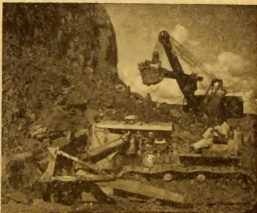
Escavadeiras no Cauê
