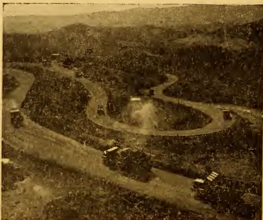
Caminhões transportando minério para os britadores
