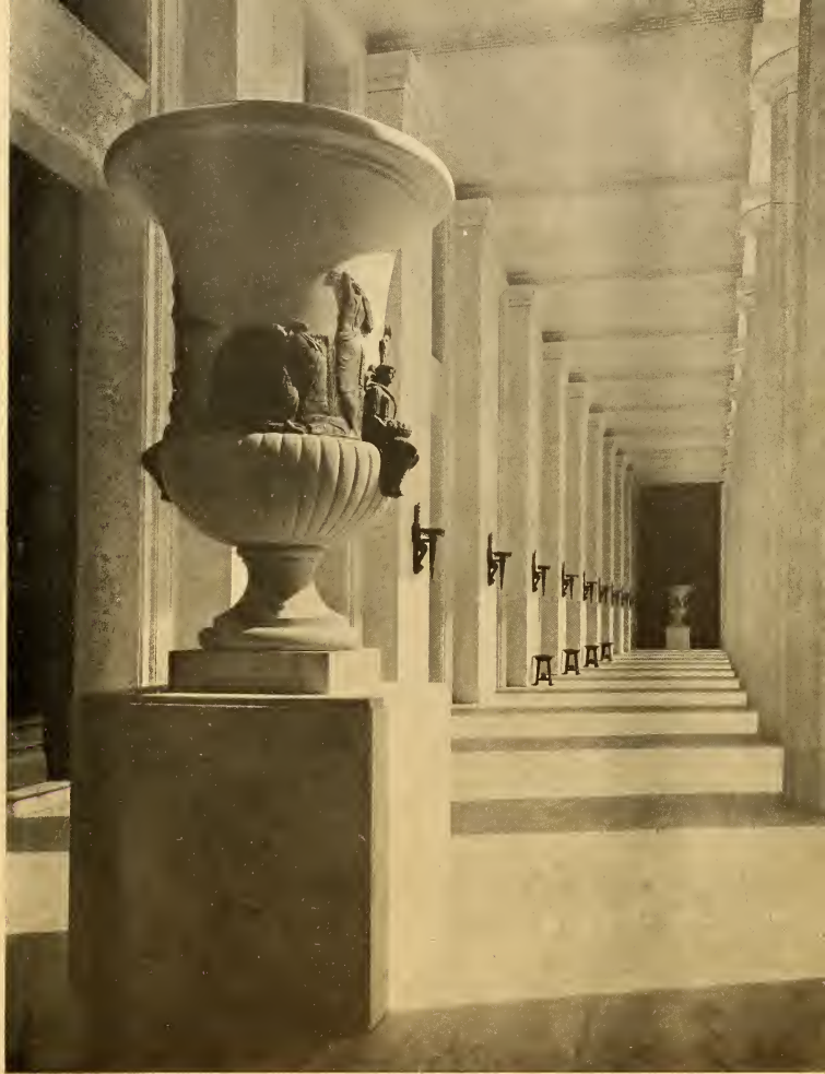
VIII — VISTA INTERNA DO PÓRTICO
