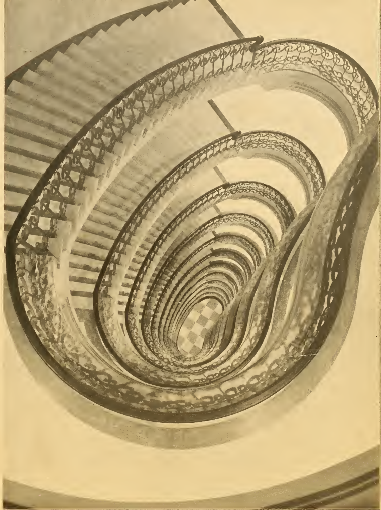
XVII — PERSPECTIVA DA ESCADA DE LIGAÇÃO DOS PAVIMENTOS
