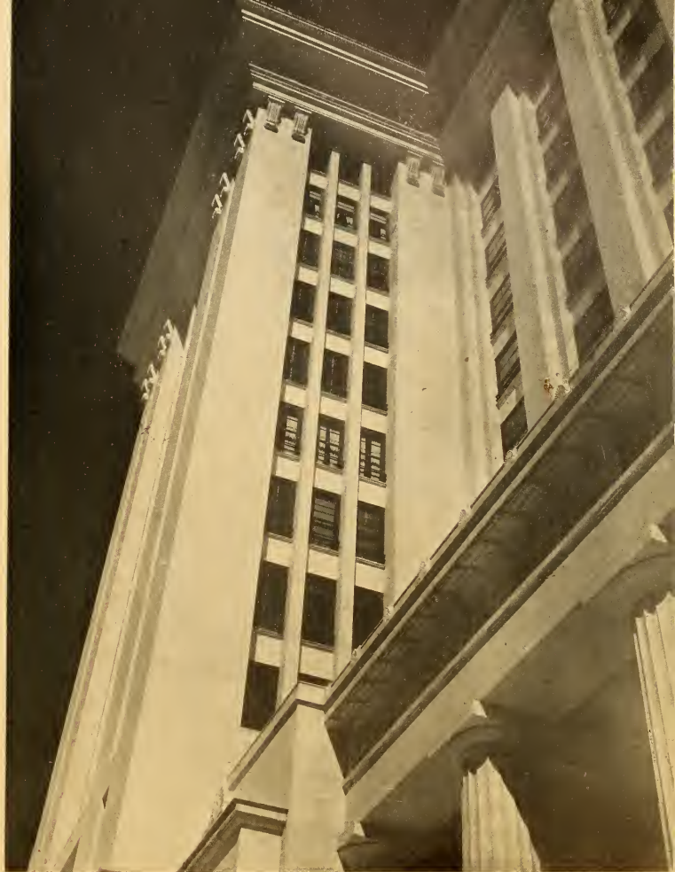
V — ÂNGULO DO EDIFÍCIO
