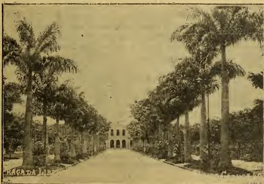
Vista do Palacio da Liberdade
