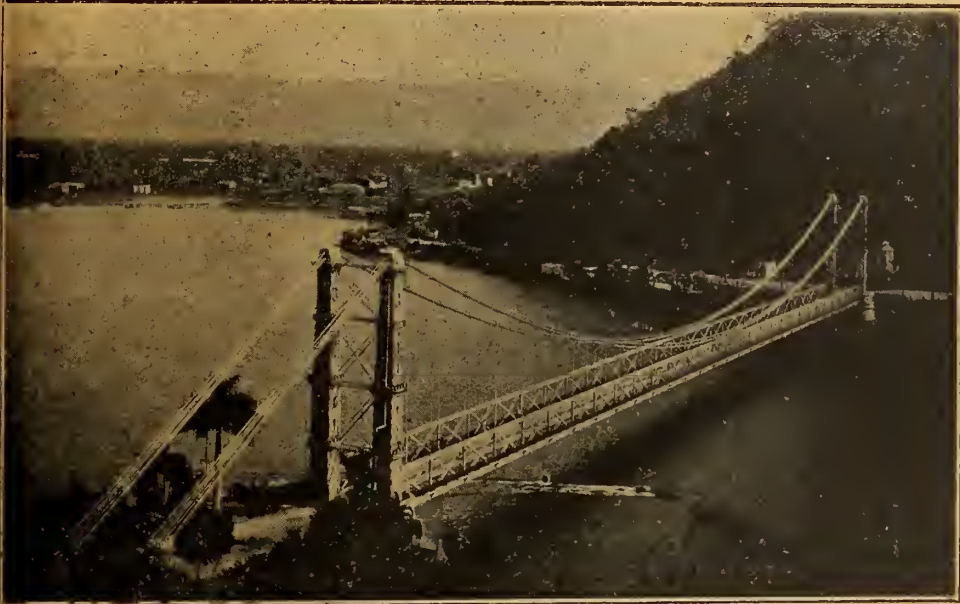
Ponte Pensil em Santos
