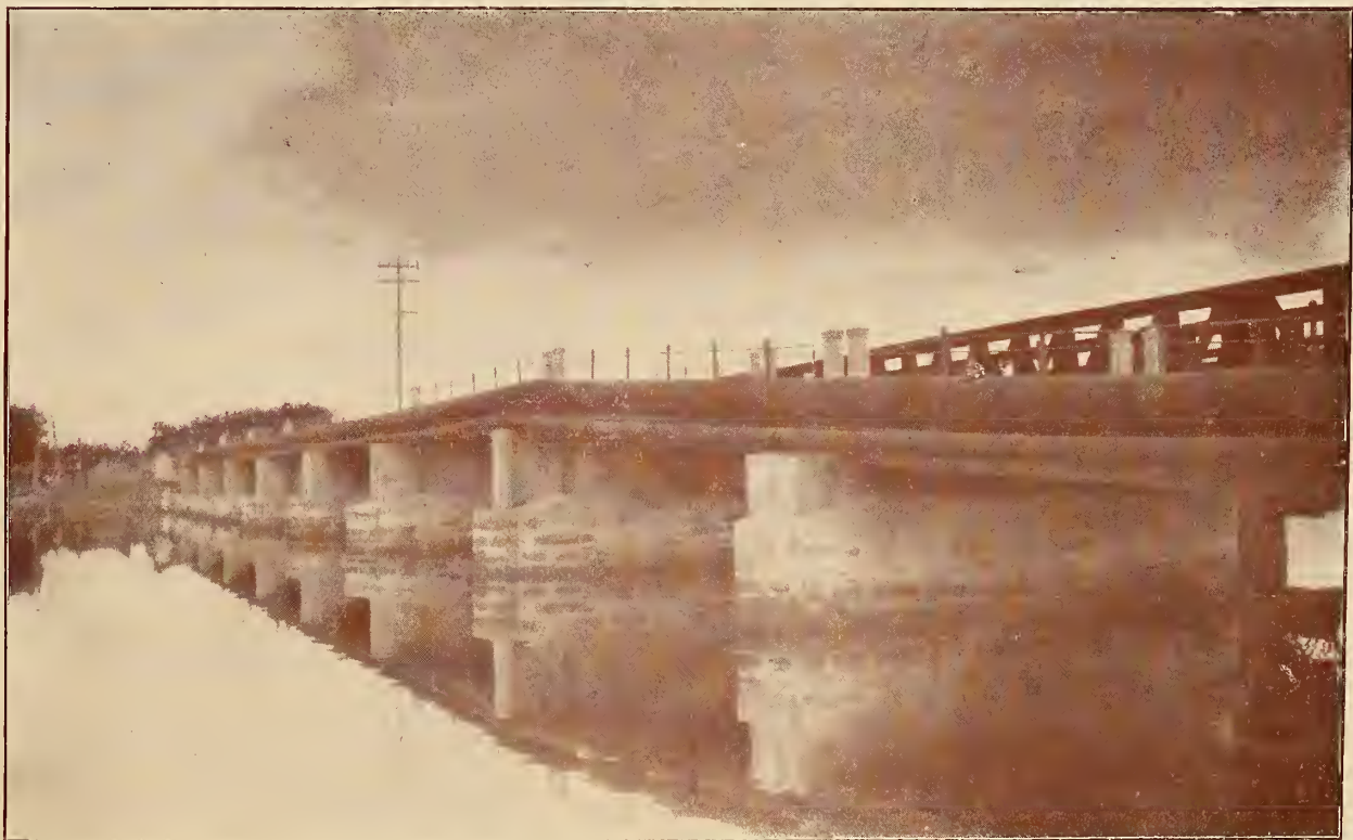
SÃO PAULO - SANTOS — Ponte sobre o rio Casqueiro. Bridge over the river Casqueiro. Puente sobre el rio Casqueiro.
