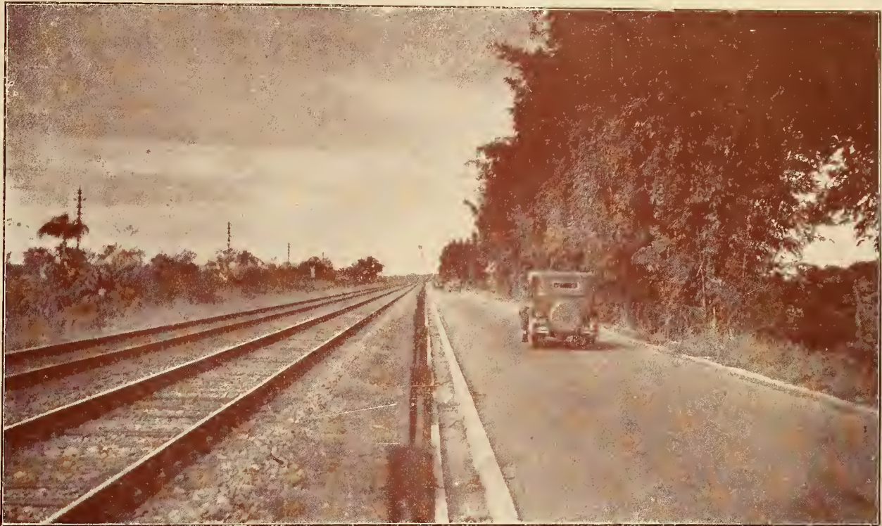
SÃO PAULO - SANTOS — Trecho em concreto asfáltico (ao lado a linha da São Paulo Railway). Stretch of asphalt-concrete (along the São Paulo Railway line). Trozo en hormigón asfáltico (al lado la vía de la São Paulo Railway).
