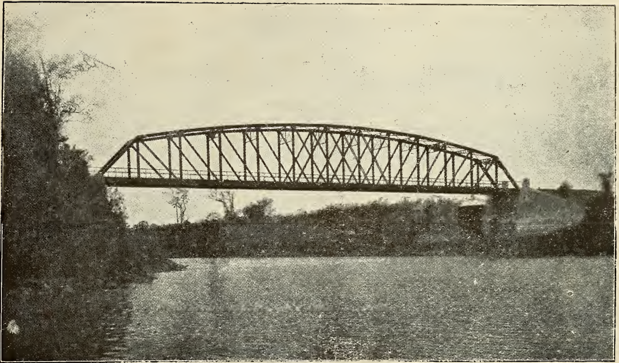
PORTO JOAO ALFREDO — Ponte sobre o rio Tieté. Bridge over the river Tieté. Puente sobre el río Tieté.
