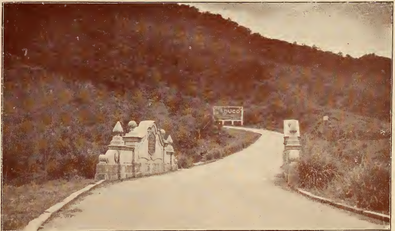
SÃO PAULO - SANTOS — Rais da Serra (fim do concreto e começo do asfalto). Foot of the mountains (end of the concrete and beginning of the asphalt). Raiz de la Sierra (fin del hormigón y principio del asfalto).
