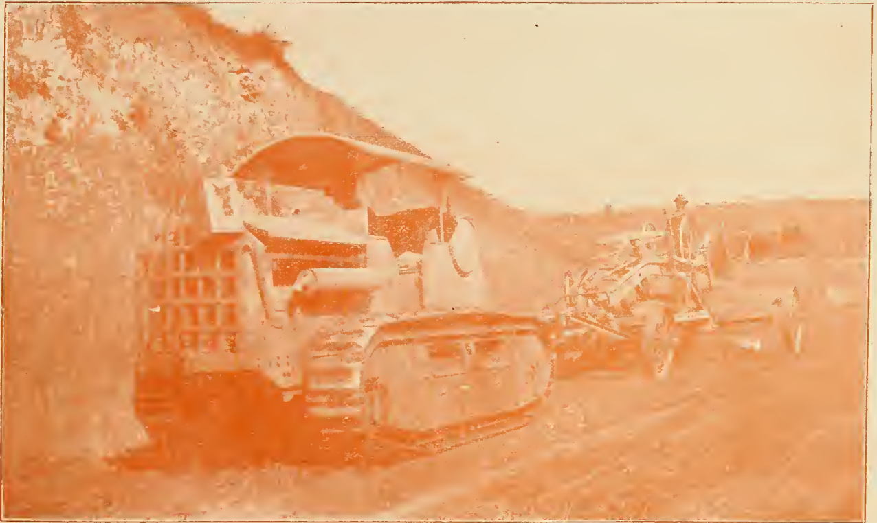
SÃO PAULO - PARANÁ — Trabalho de platina mecânica. Upkeeping by graders. Trabajo de allanadora mecánica.
