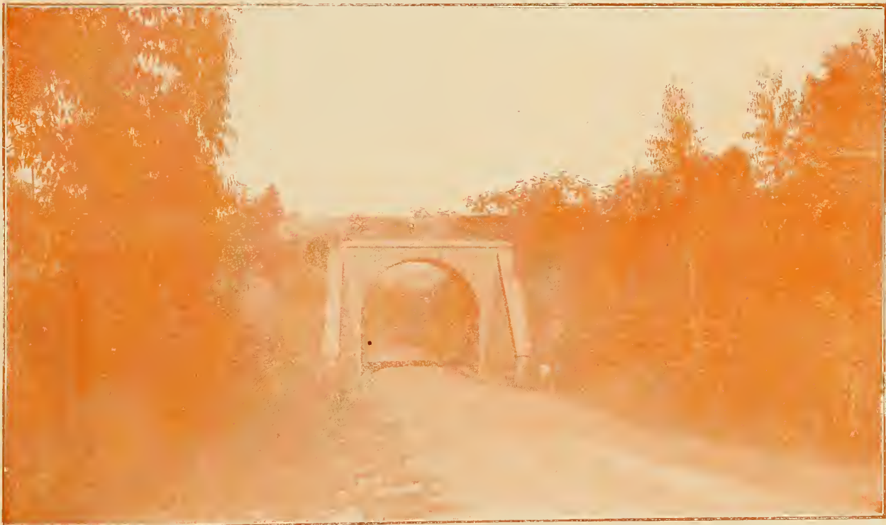
SÃO PAULO - PARANÁ — São Roque - Sorocaba (passagem inferior). (under crossing). (paso inferior).
