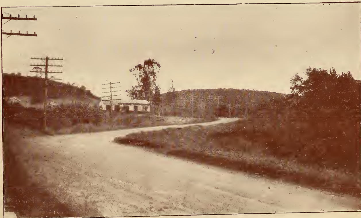
SÃO PAULO - SANTOS — Trecho em pedregulho com base de macadam. Graveled stretch on macadam base. Trozo en cascajo con base de macadam.
