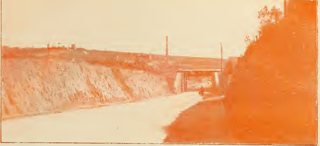
SÃO PAULO - PARANÁ — São Roque - Sorocaba (passagem inferior). (under crossing). (paso inferior).
