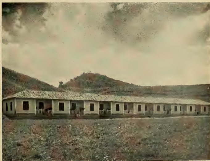
Casas para trabalhadores rurais — Usina Catende
