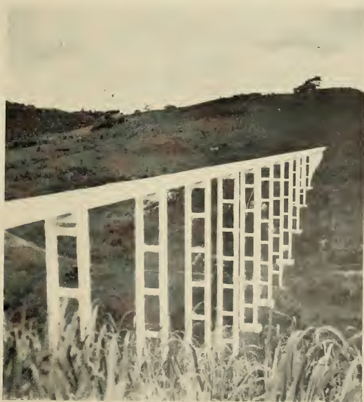
Aqueduto de cimento armado — Usina Tiuma
