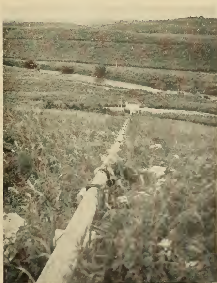
Água bombeada — Usina Tiuma
