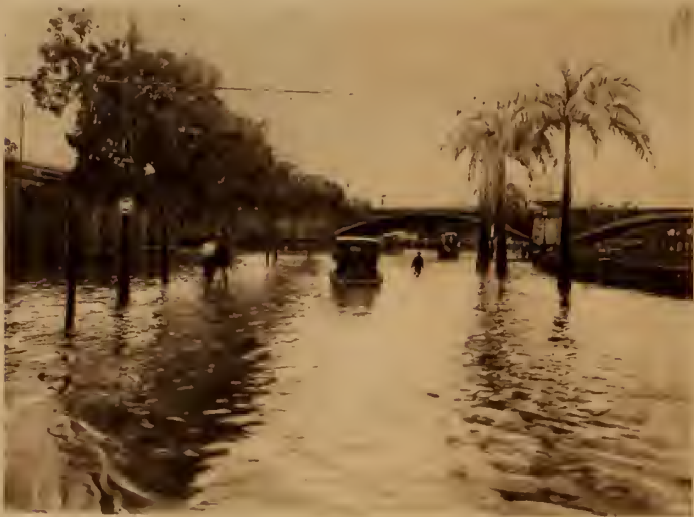
Fig. 12. — Avenida Francisco Bicalho. Inundaçào em 27 de Fevereiro de 1928.
