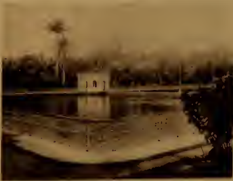
Fig. 2. — Captação do Rio d'Ouro. Bacia de decantação.
