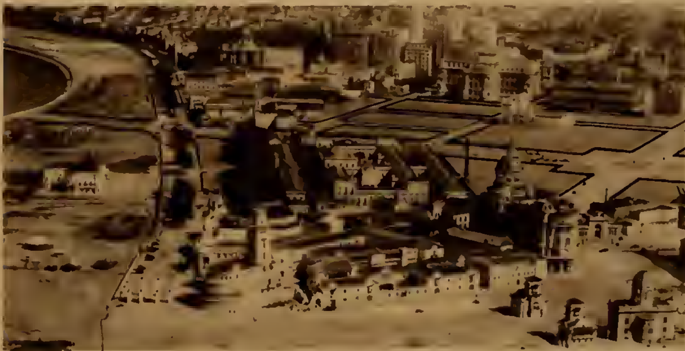
Fig. 13. — Esplanada do Castello no estado actual com o arruamento em execução.
