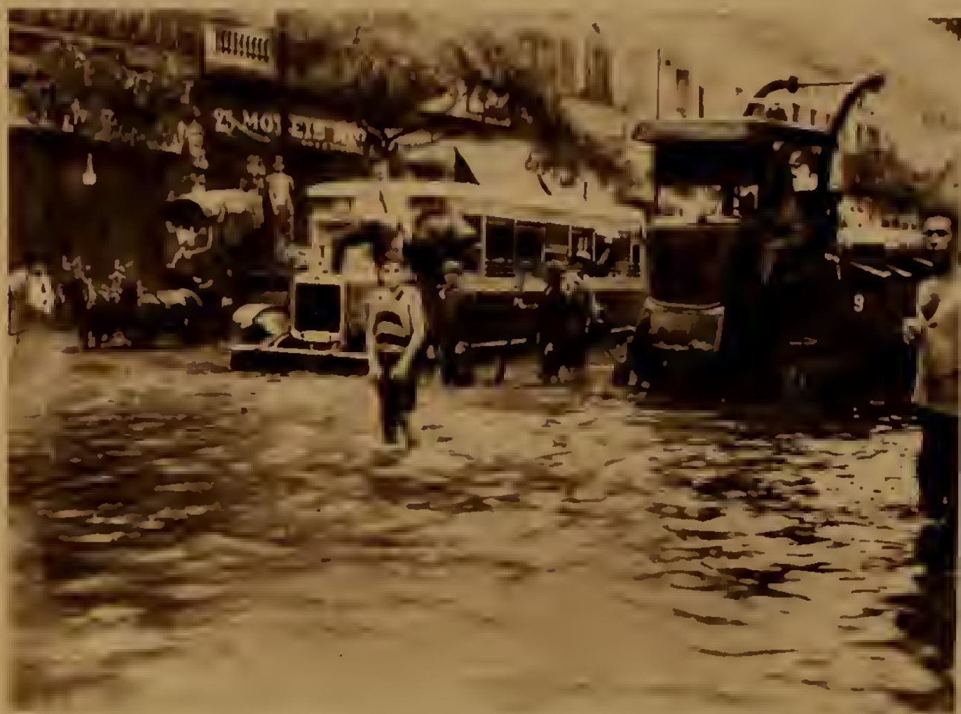
Fig. 9. — Rua do Cattete. Inundaçãõ em 27 de Fevereiro de 1928.
