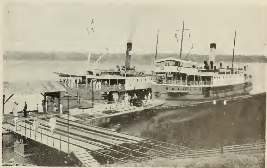
Fig. 68 - Porto Velho - extremo da navegação do rio Madeira e início da E. F. Madeira-Mamoré
