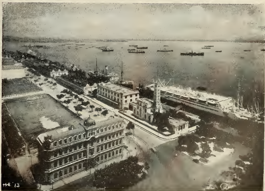
Fig. 82 — Trecho do pôrto do Rio de Janeiro, D. F.
