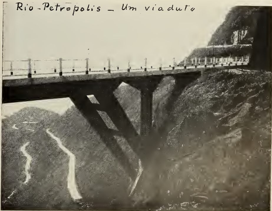
Fig. 56 - Rio-Petrópolis - Um viaduto, vendo-se também um trecho da estrada
