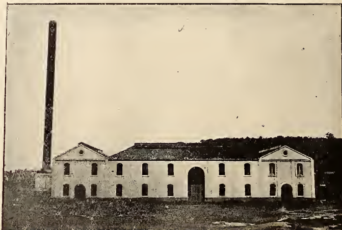
Usina Terra Nova (Bahia)—Vista de fundo
