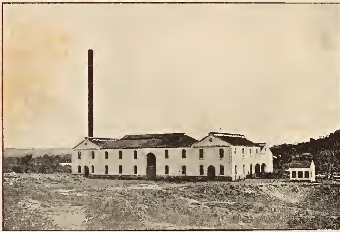
Usina Terra Nova (Bahia)—Vista geral
