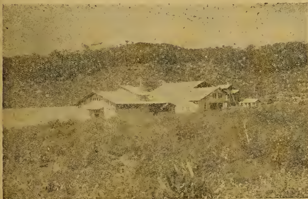
Usina de tratamento e jazida de amianto em Bom Jesus, Poções, Baía
