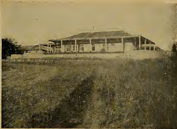
Fazenda Experimental de Criação, em Bagé — Rio Grande do Sul -- Casa antiga remodelada
