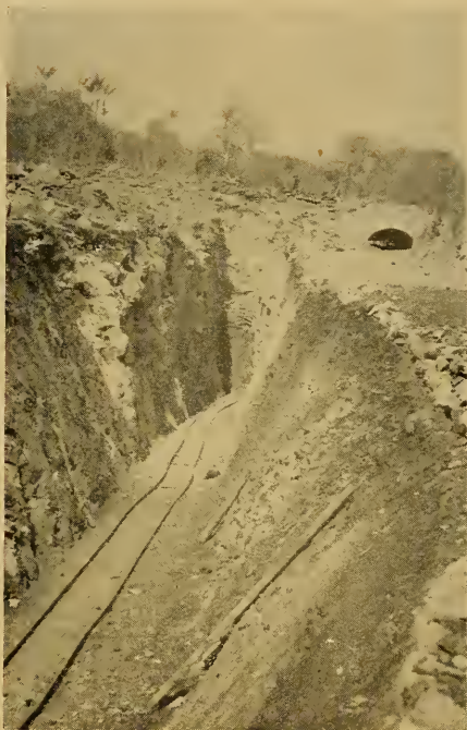
Mina de Amianto — Bom Jesus — Poções — Estado da Baía — Entrada da primeira galeria de exploração — Setembro de 1939
