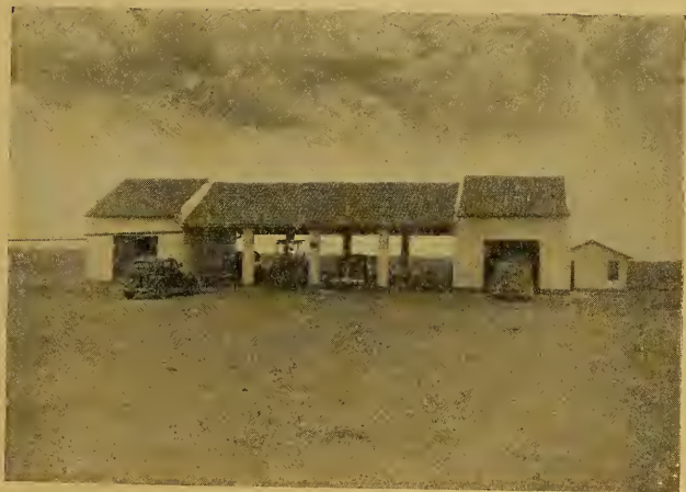
Estação Experimental "Valbert Pereira", em Serra Verde — Rio Grande do Norte — Galpão de máquina, Oficina e Garage
