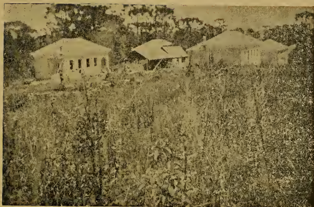
Estação Experimental de Trigo, em Caçador — Santa Catarina — Grupo de residências
