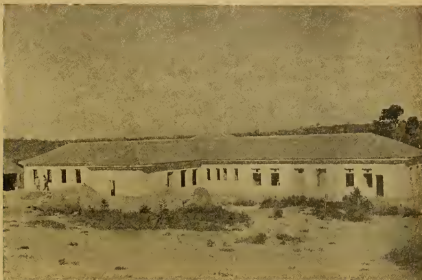
Estação Experimental de Trigo, em Ipanema, São Paulo — Edifício principal
