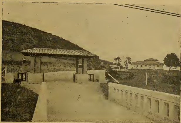
Secção de Investigações Fitossanitárias em São Bento — Pontilhão e Pórtico
