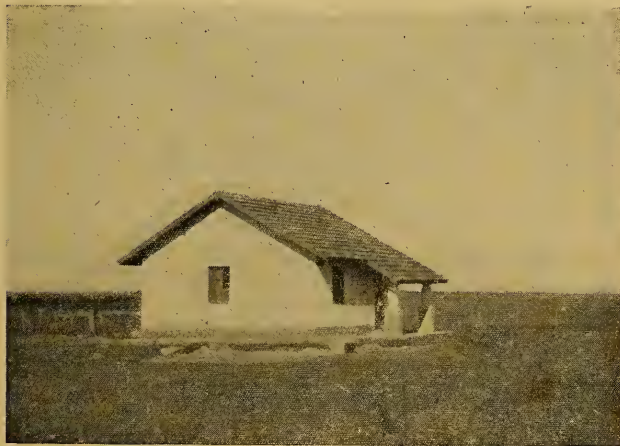
Fazenda Experimental de Criação, em Bagé — Rio Grande do Sul — Um das casas de trabalhadores, construídas em diversos pontos da Fazenda
