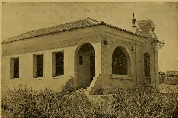
Estação Experimental de Trigo, em Ipanema, São Paulo — Residência do Diretor
