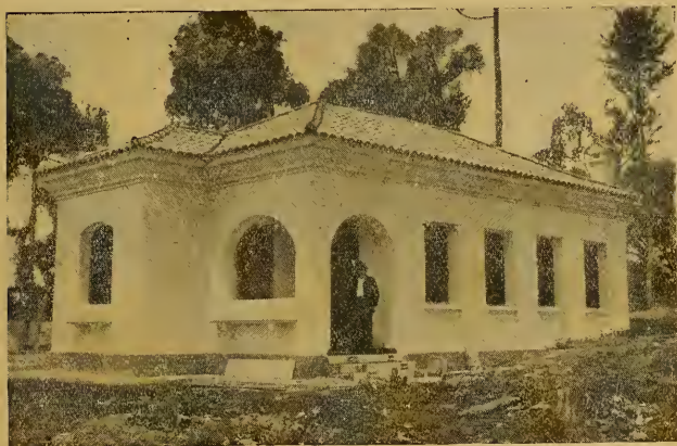
Estação Experimental de Trigo, em Passo Fundo — Rio Grande do Sul — Residência do Auxiliar
