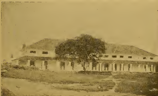
Instituto Agronômico do Norte — Pará — Laboratório
