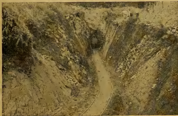
Talho de acesso à exploração de amianto em Bom Jesus, Poções Baía
