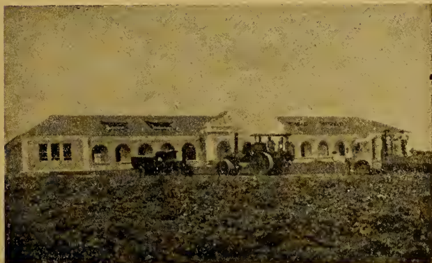
Estação Experimental de Trigo, em Curitiba, Paraná — Edifício da Administração e Laboratório
