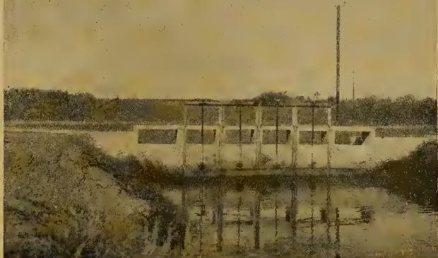
Núcleo Colonial Santa Cruz — Comporta em canal de irrigação
