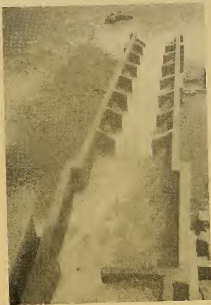
Escada de peixes na barragem da usina de Emas — Pirassununga — São Paulo
