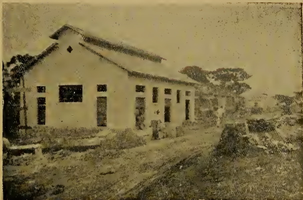
Estação Experimental de Trigo, em Rio Caçador — Santa Catarina — Casa de Máquinas
