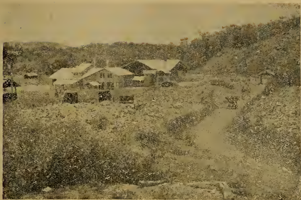
Amianto em Bom Jesus, Poções, Baía — Vista da jazida à direita, linha de transporte, balança registradora e usina de tratamento
