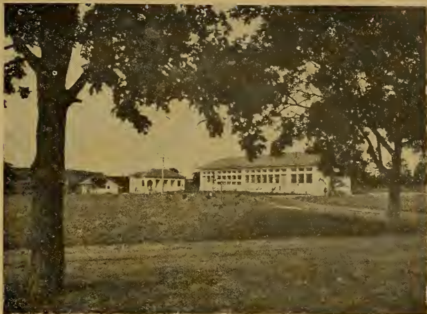
Estação Experimental de Piscicultura em Pirassununga — São Paulo — Edifício principal, residência do auxiliar, garage e depósito de máquinas
