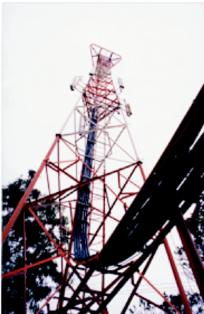
Foto - Torre de Telefonia Celular no bairro Belvedere em BH/MG Eugênio Gurgel-IBGE/DERE/SE2
