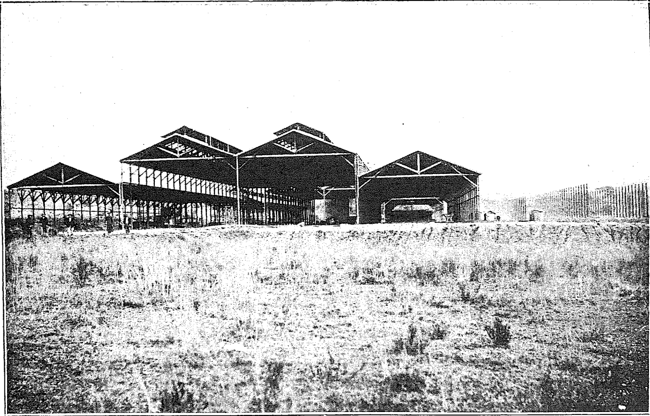
Outros pavilhões em construção no Kilometro 3, proximo de Santa Maria, para as novas officinas de carros e vagões.
